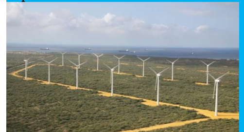
Aerogeneradores del parque Eólico de Paraguaná.
