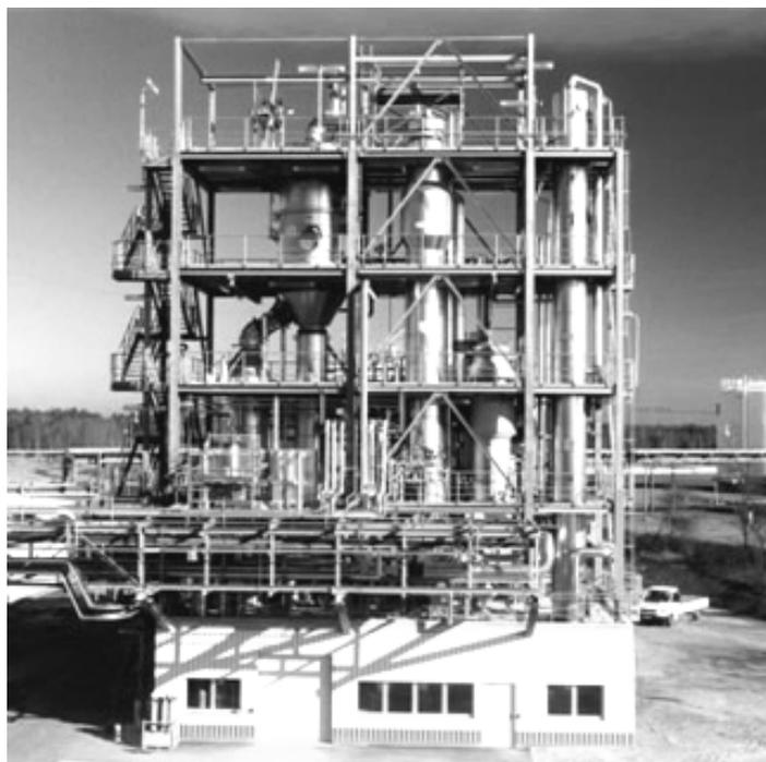
Figura 3. Planta de evaporación de dos efectos con evaporador de recirculación forzada para agua de desecho.[5]
