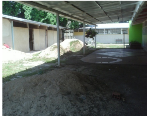
Foto 5. Cancha en construcción
