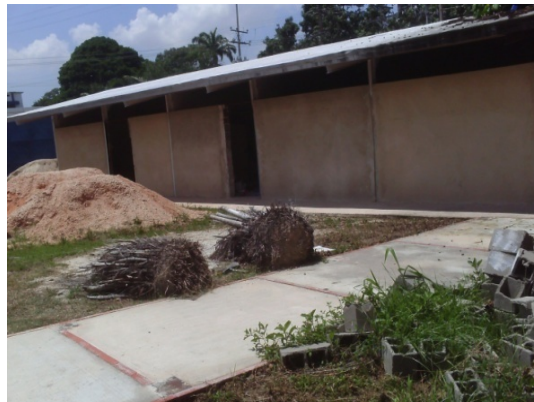
Foto 6. Cocina en construcción
