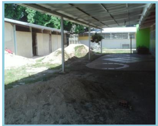
Foto 4. Cancha en construcción
