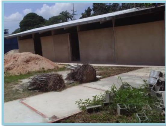
Foto 5. Cocina en construcción
