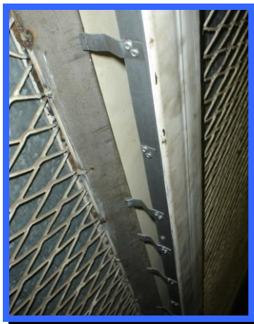
Fig. 71 Sistema de unión por pletinas del portón.
