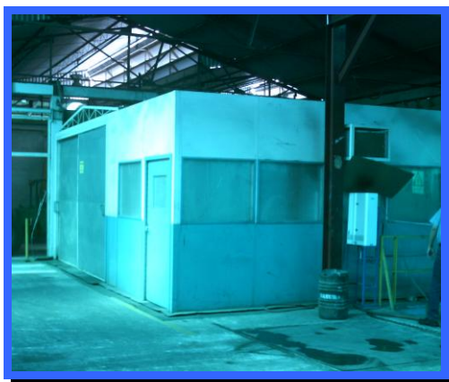
Fig. 67 Jaula de Faraday que conforma el laboratorio de alta tensión de la empresa ARALVEN S.A.
