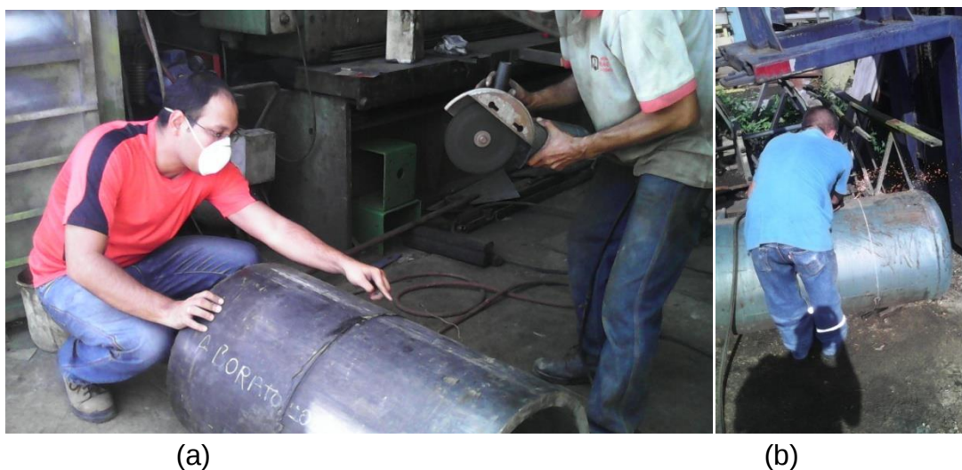
Figura 5. Trabajos de corte a los materiales disponibles para la construcción de: (a) los reactores de biopelículas sumergidas móviles y (b) sedimentador.
