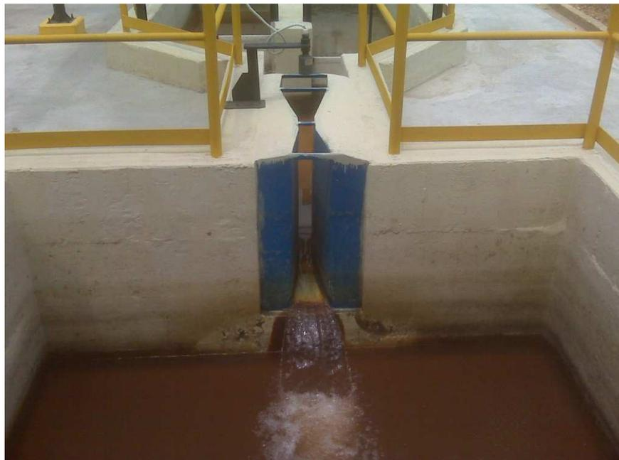
*Figura 41.* **Tanque de igualación aforador Parshall, “Planta Coca-Cola en Panamá”.** *Nota. Pottellá Tulio (2011)*
