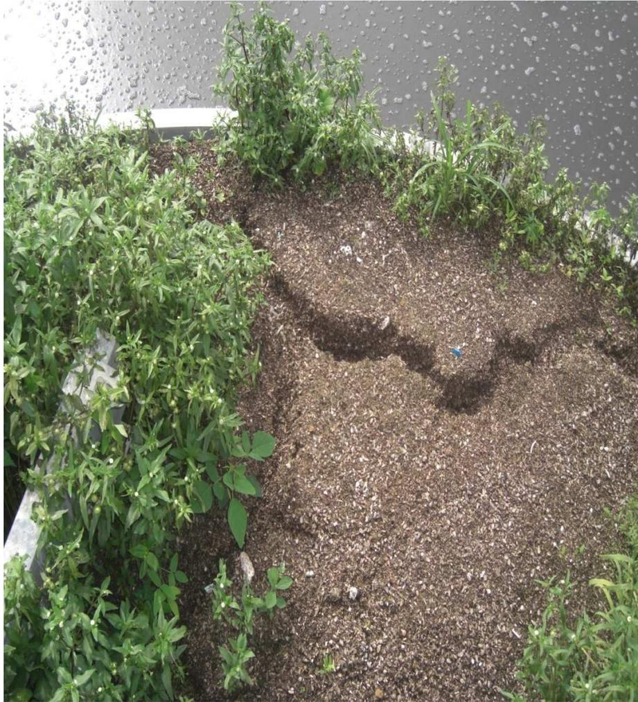
*Figura 50.* **Acumulación de sedimentos PTAR “La Mariposa”** *Nota.* Fabio Padoan (2010)
