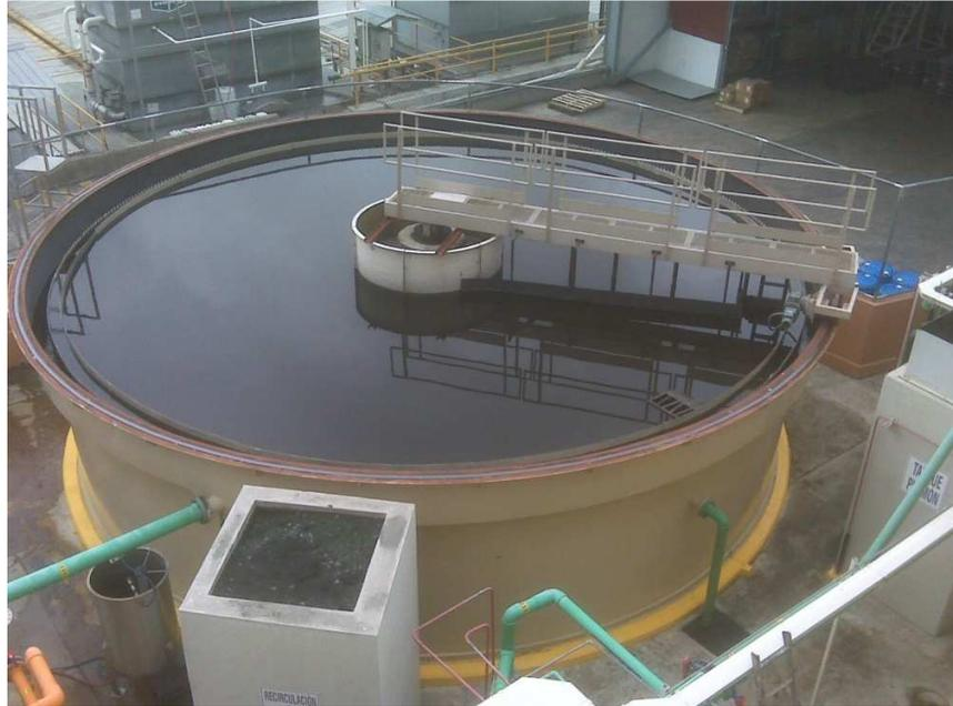
**Figura 44. Tanque sedimentador. Planta Coca-cola en Panamá**
