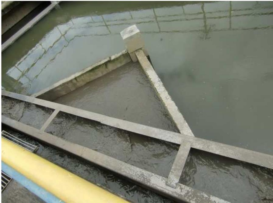
*Figura 17.* **Salida de lodos del tanque sedimentador, “Los Chorritos”.** *Nota.* Altuve y Ramírez (2011)
