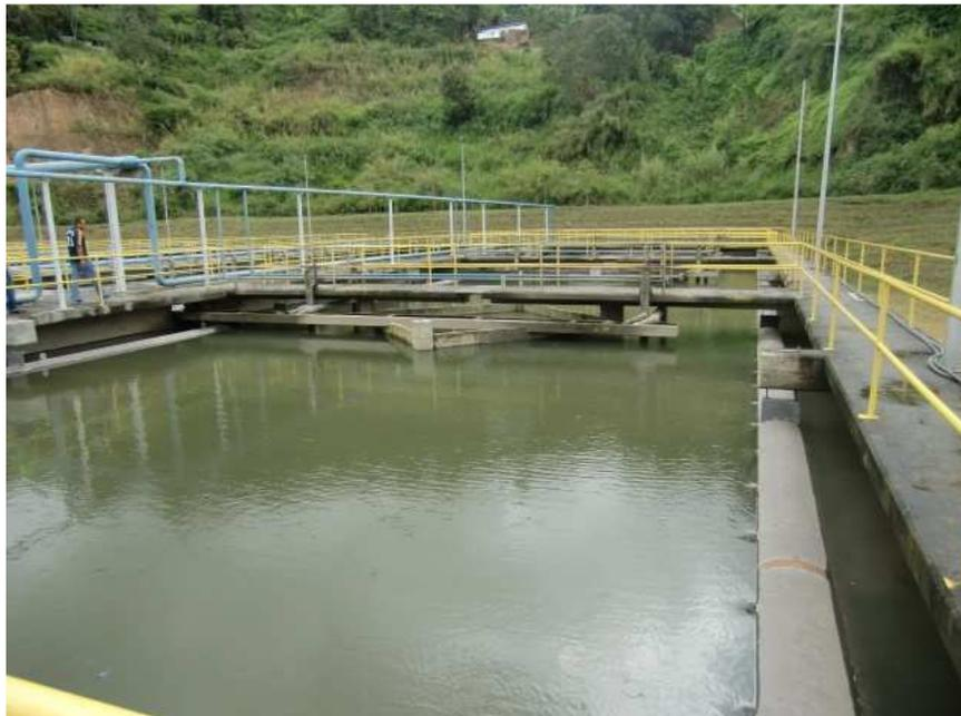
**Figura 12. Sedimentador Planta “El Chorrito”.**
