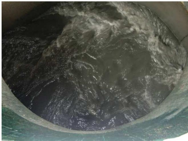
*Figura 10.* **Desarenador tipo ciclón Planta “El Chorrito”**
