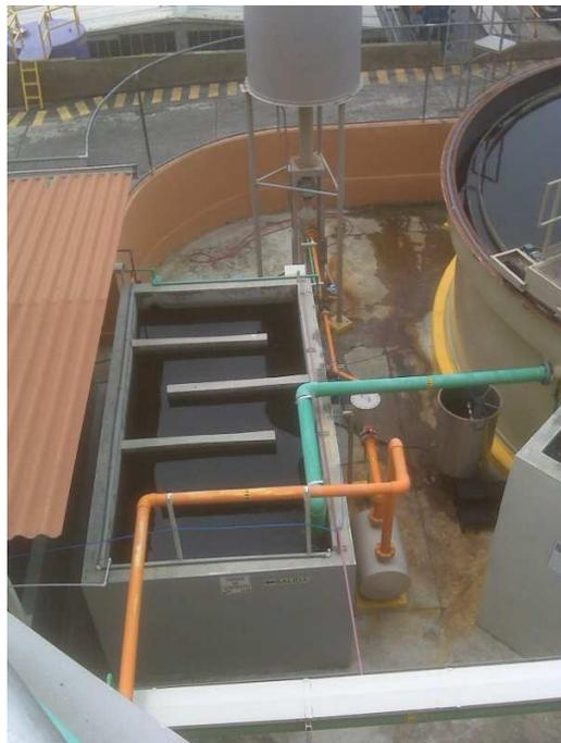
**Figura 45. Tanque de cloración. Planta “Coca-cola” en Panamá.** *Nota. Pottellá Tulio (2011)*
