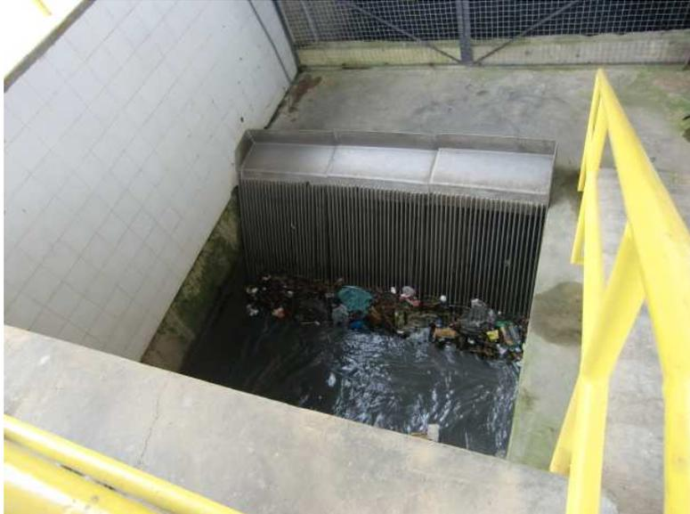
*Figura 9.* **Sistema de desbaste planta “El Chorrito” edo. Miranda**
