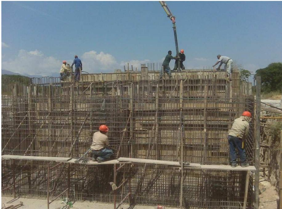
*Figura 24.* **Construcción del tanque de igualación**
