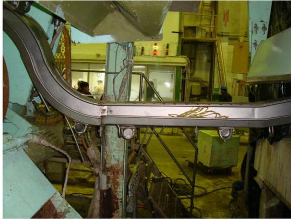
Figura N° 93. **Montaje del ducto de transferencia yankee-reel**
