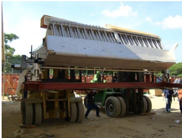
Figura N° 137. Maniobra con dos montacargas para ubicación caja de entrada en camión.
