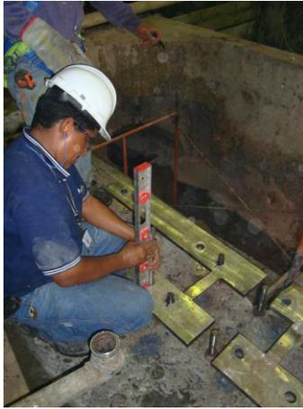
Figura N° 74. Ubicar los insertos usando los anclajes existentes.
