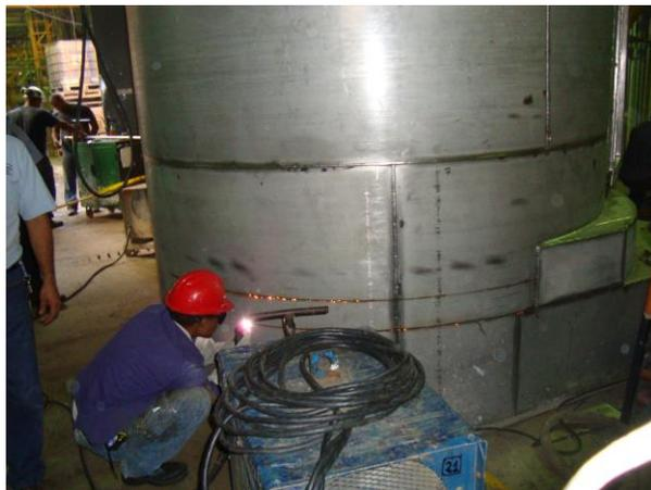
Figura N° 114. **Corte del ciclón para ajustes con la pieza de transición**
