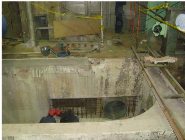
Figura N° 79. **Montaje de tubería y fabricación de muro interno en el wire pit.**
