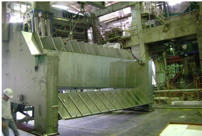
Figura N° 119. Desmontaje del monobloque sobre área reforzada en losa
