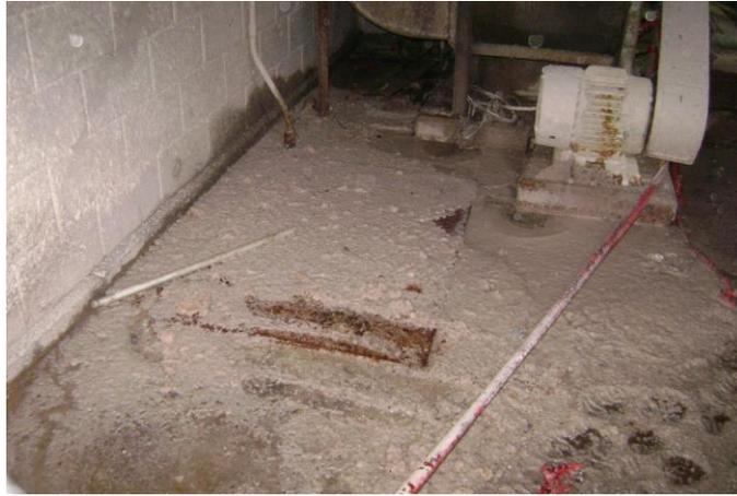
Figura N° 21. Corte de losa para pase de ducto de ventilación del ciclón.
