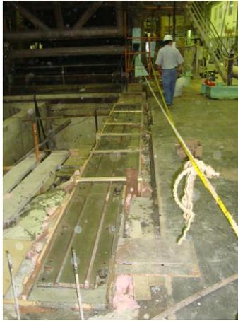
Figura N° 77. **Alineación y nivelación final para vaciado de grouting.**
