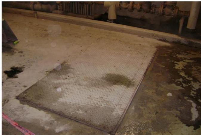
Figura N° 23. Corte de losa para pase de tuberías de agua blanca.
