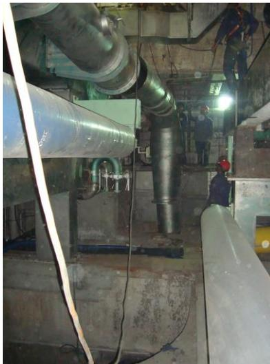
Figura N° 140. Presentación de tubería de aproximación con tubo alimentación caja de entrada
