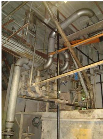
Figura N° 87. **Fabricación de tubería circuito agua clarificada molino.**
