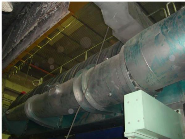
Figura N° 141. Replanteo entre tuberías para realización de corte y soldadura
