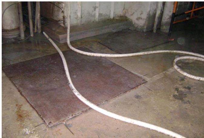
Figura N° 22. Corte de losa para pase de tubería de aproximación y tensores de cantilever.
