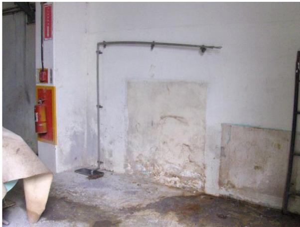
Figura N° 28. **Corte de losa para pase de tubing y tuberías de reubicación de químicos.**
