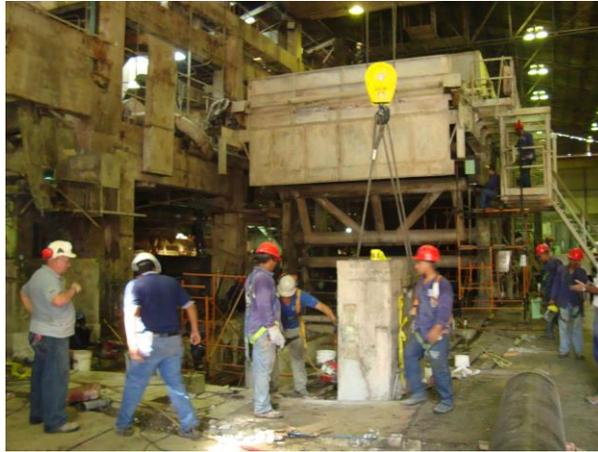
Figura N° 56. Corte y movilización de bases de concreto de la caja entrada
