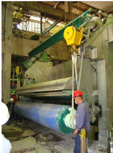
Figura N° 123. **Montaje del rodillo tela 2.03.**
