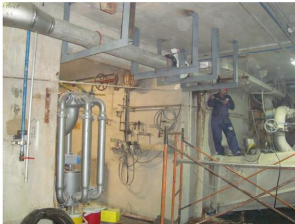
Figura N° 84. Instalación tramo inicial tubería de recirculación.
