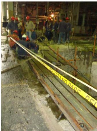
Figura N° 76. Sujetar los pernos de anclaje en los insertos, prelinear y prenivelar.
