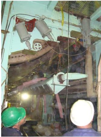
Figura N° 91. **Montaje y presentación en sitio de los elementos estabilizadores de hoja.**
