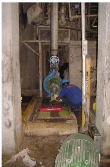
Figura N° 97. **Cambio impulsor bomba agua clarificada**
