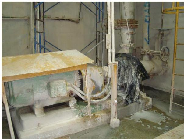
Figura N° 96. **Cambio impulsor bomba agua clara baja presión**
