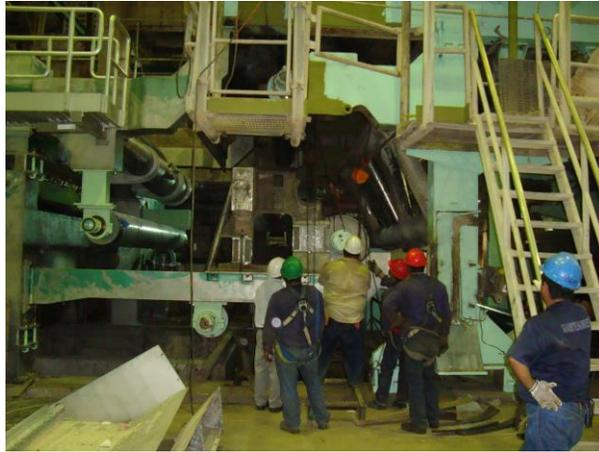
Figura N° 139. Montaje del rodillo motriz fieltro 4.15
