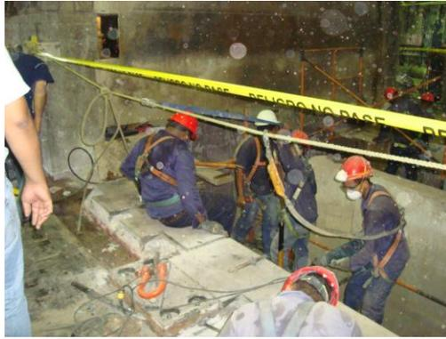
Figura N° 71. Retirar las placas de fundación existentes.
