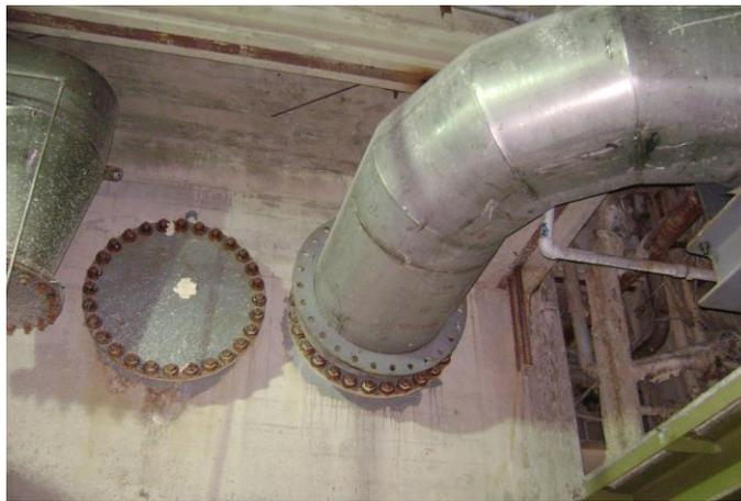
Figura N° 13. **Instalación de tuberías en tanque de agua blanca (parada larga previa)**
