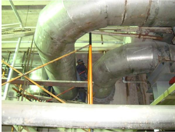
Figura N° 82. Instalación de tuberías agua blanca del canalón.
