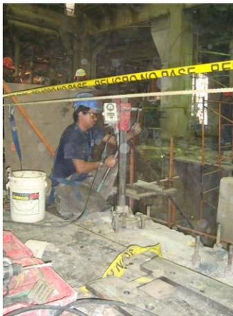
Figura N° 75. Ubicar nuevos agujeros en la viga de concreto para ubicación de nuevos pernos.
