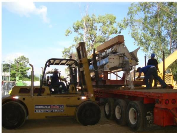
Figura N° 138. Colocación de la caja de entrada en la plataforma del camión.
