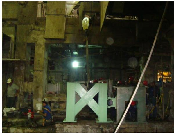
Figura N° 110. **Montaje base accionamiento rodillo guía fieltro (etapa inicial)**
