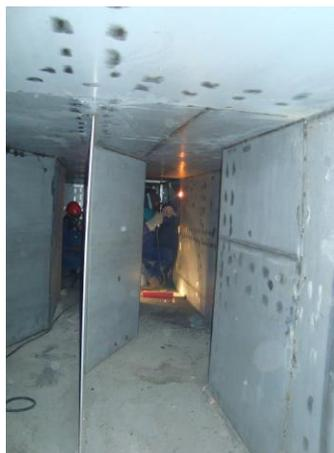
Figura N° 105. **Soldadura de los diferentes sectores (sector intermedio-parte inicial)**
