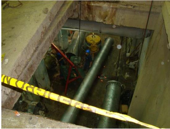
Figura N° 85. **Movilización al sotano de tuberías del sistema de aproximación de agua blanca.**
