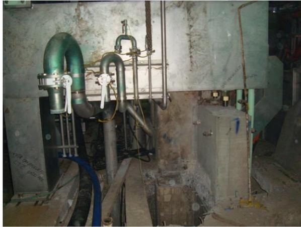
Figura N° 142. Conexión de manifold de duchas lado fieltro
