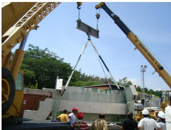
Figura N° 48. **Adiestramiento en la ejecución de maniobra e implementos para giro con éxito.**
