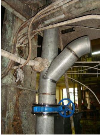
Figura N° 88. Fabricación tubería agua baja presión hacia make up canalón.
