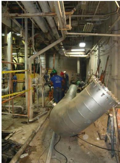
Figura N° 86. **Instalación de tuberías sistema de aproximación de agua blanca.**
