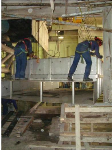
Figura N° 103. **Culminación de la maniobra de acceso de la última parte del canalón**
