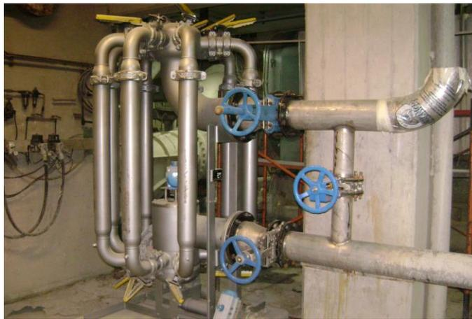
Figura N° 16. **Instalación de Filtros**
