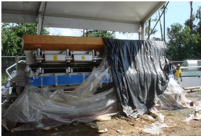
Figura N° 38. Preparación y organización de partes en el patio de almacenamiento según secuencia de montaje
