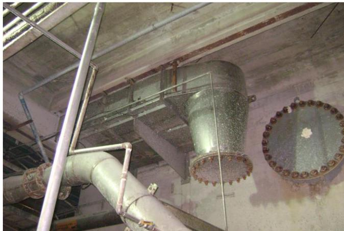
Figura N° 14. **Instalación de cajón de rebose en tanque agua blanca (parada larga previa)**
