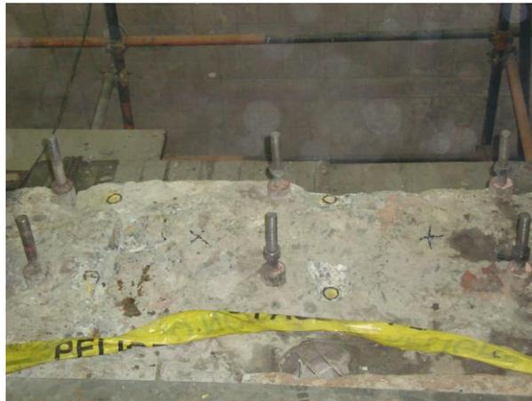
Figura N° 73. Limpieza de pernos de anclaje existentes.
