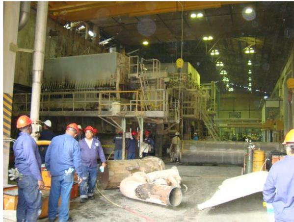
Figura N° 67. Desmontaje de tubería de vacío del rollo pecho.
