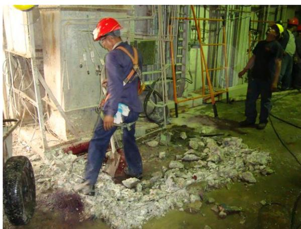
Figura N° 52. **Demolición de brocales del sistema de químicos.**
