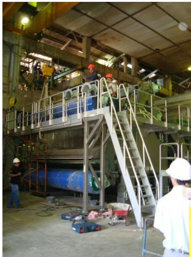
Figura N° 131. Montaje pasillos transversales lado rodillo tela 2.04
