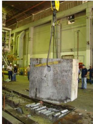
Figura N° 70. Desmontaje de las bases de concreto caja de entrada.
