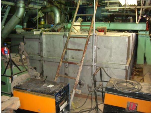
Figura N° 106. **Vaciado del grouting del canalón.**
