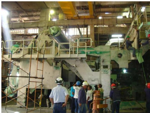
Figura N° 129. Montaje de pasillos longitudinales LF lado formador
