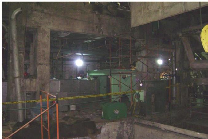
Figura N° 111. **Montaje base accionamiento rodillo guía fieltro (etapa final)**
