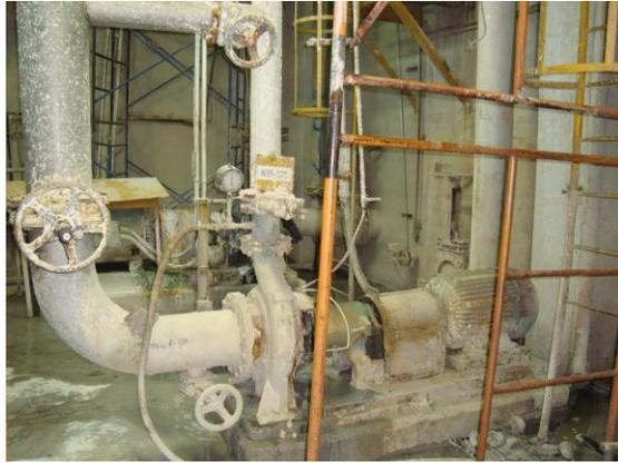
Figura N° 95. **Cambio de impulsor y motor bomba agua clara media presión**
