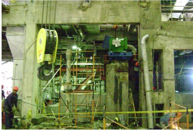
Figura N° 109. **Montaje accionamiento rolo formador**
