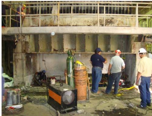
Figura N° 69. Corte de las bases de concreto de la caja de entrada.
