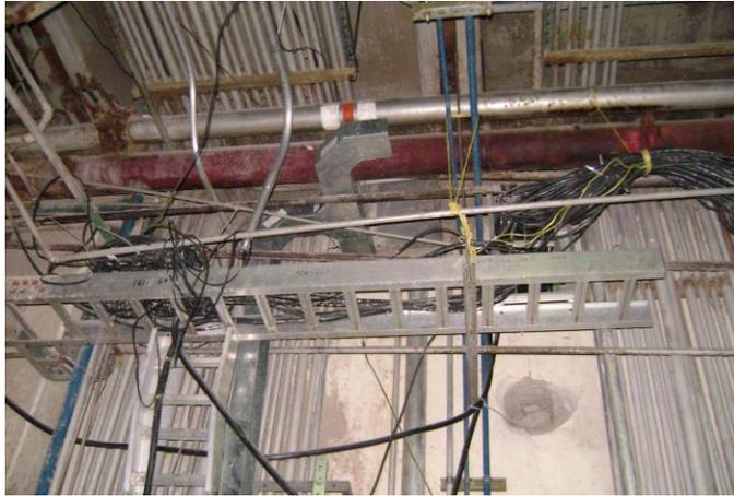
Figura N° 9. **Instalación de bandejas para conducción del cableado de cuarto eléctrico a la máquina.**
