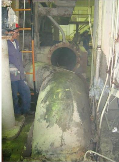
Figura N° 66. Desmontaje de tubería de aproximación agua blanca.
