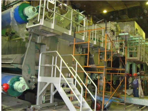
Figura N° 130. Montaje pasillos longitudinales LF lado caja entrada
