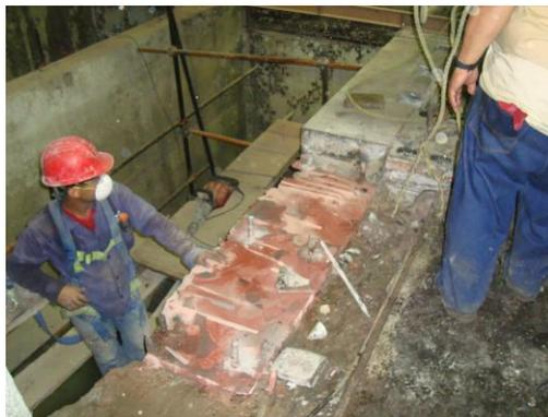
Figura N° 72. Liberación de la primera placa de fundación.
