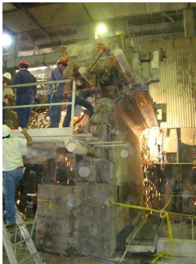
Figura N° 54. **Corte y desmantelamiento de la parte superior caja de entrada.**
