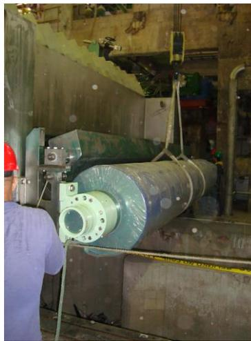
Figura N° 122. **Montaje del rodillo tela 2.02.**
