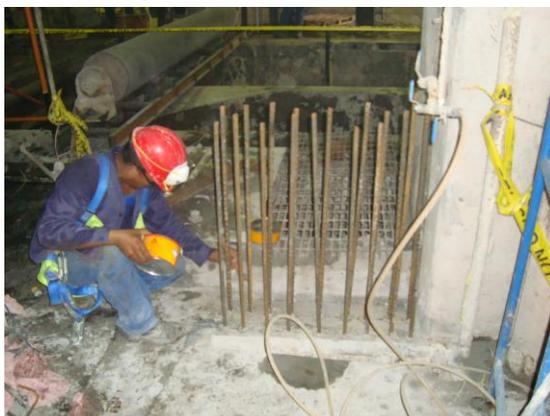
Figura N° 80. **Construcción base soporte cantilever CT2-CT3.**
