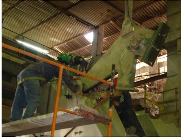
Figura N° 124. **Montaje de la palanca LF rodillo tela 2.05.**
