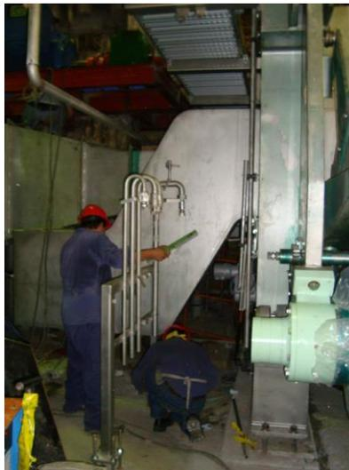
Figura N° 128. Montaje de manifold de duchas sección tela.
