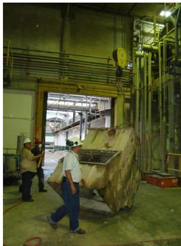
Figura N° 68. Desmontaje del ducto-bandeja recolección de agua de máquina.
