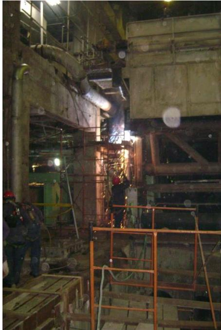
Figura N° 98. **Instalación de plancha soporte para rodillos reubicados**
