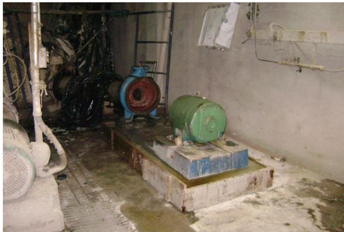
Figura N° 17. **Reubicación de bomba de mezcla.**
