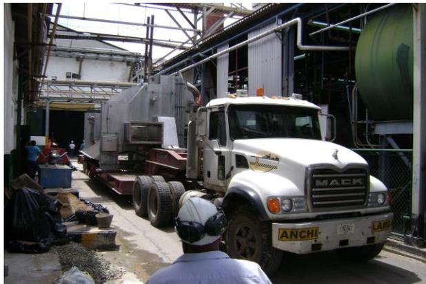
Figura N° 117. Movilización del Monobloque hacia galpón
