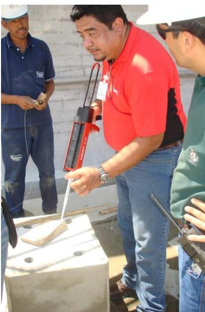
Figura N° 31. Adiestramiento en uso del producto especificado para anclaje químico.
