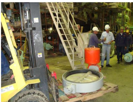
Figura N° 81. **Movilización al sótano de válvula de control de agua blanca.**
