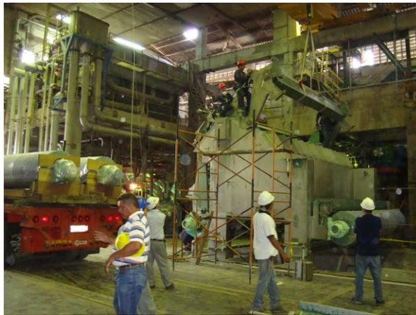
Figura N° 125. **Montaje del raspador rodillo tela 2.05.**
