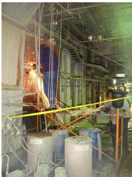
Figura N° 49. **Preparación de tie in de tuberías involucradas en el proceso (cortes programados de servicios para colocación de válvulas manuales)**
