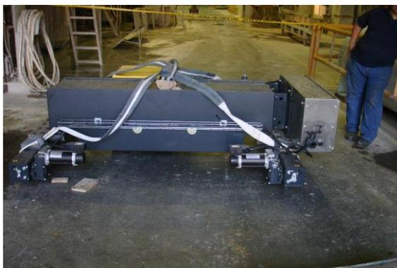
Figura N° 30. Cambio de polipasto 12ton por nuevo polipasto capacidad 20 ton.
