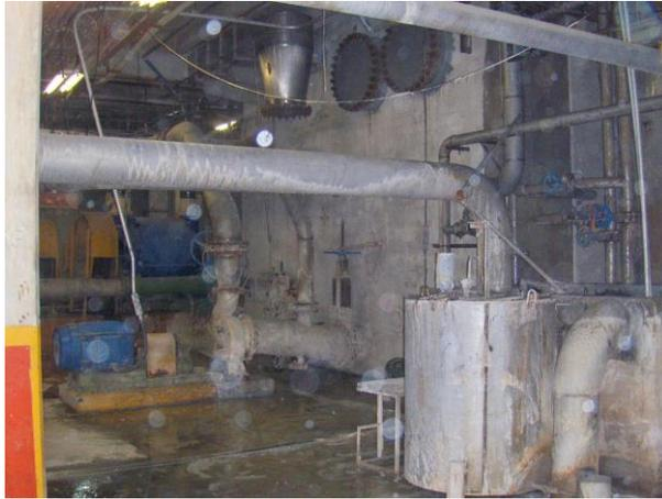
Figura N° 27. **Reubicación de tuberías que interfieren con tuberías de agua blanca.**
