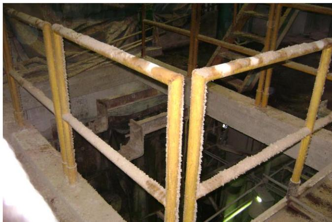
Figura N° 20. Corte de losa y construcción de acceso a accionamiento del rollo formador.
