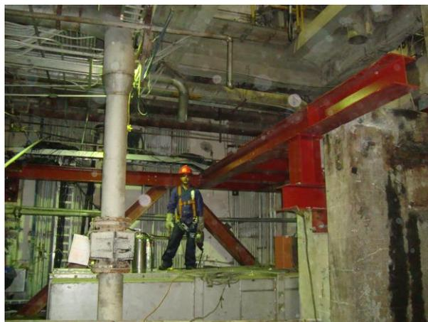
Figura N° 108. **Montaje base accionamiento rolo formador (etapa final)**
