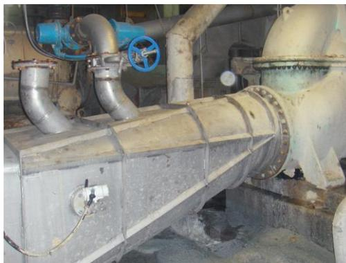
Figura N° 26. **Instalación de pieza de succión de la bomba de circulación (parada larga previa)**
