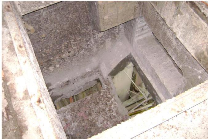
Figura N° 78. **Corte de losa en wire pit para paso de tuberías y tensores cantilever.**
