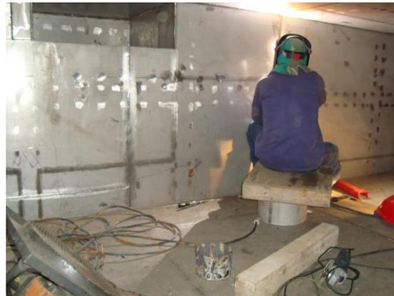
Figura N° 104. **Soldadura de los diferentes sectores (parte final-sector intermedio)**
