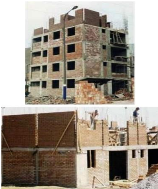
Figura 6 Construcción de Edificación con mampostería confinada. Nota. Datos tomados de: ( www.scielo.go.ve )
