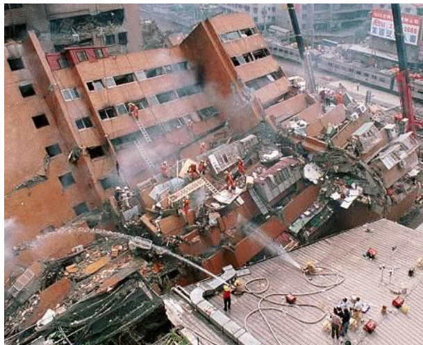
Figura 1 . Edificio colapsado durante el Terremoto de Sichuán, China en 2008.
