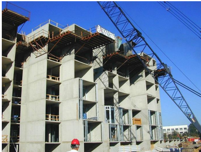
Figura 5 Construcción de Edificio tipo túnel. Nota. Datos tomados de: ( www.civil.cicloides.com )
