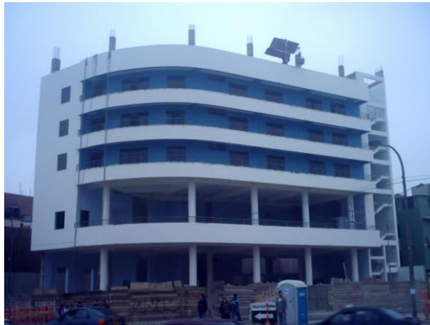
Figura 7 Entrepiso Débil Nota. Datos tomados de: ( www.sismosafari.blogspot.com )
