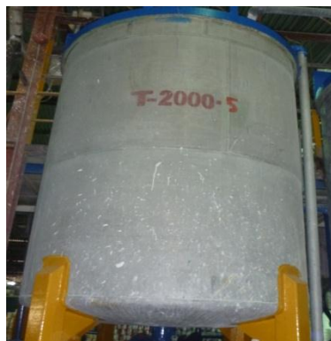
Figura N° 15. Tanques Tt-2000 (Cap: 2000gal)
