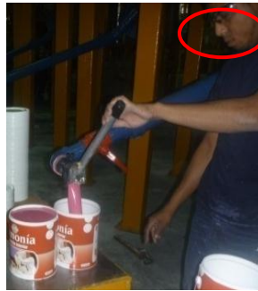
Figura N° 49. Falta de uso de EPP de los operarios
