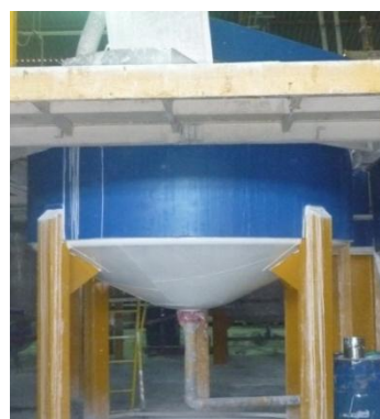
Figura N° 13. Tanques Tt-4000 (Cap: 4000gal)
