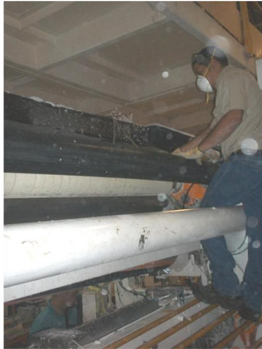
**Figura N° 22. Lubricación de puntos ubicados a una altura mayor a 1.70 m**
