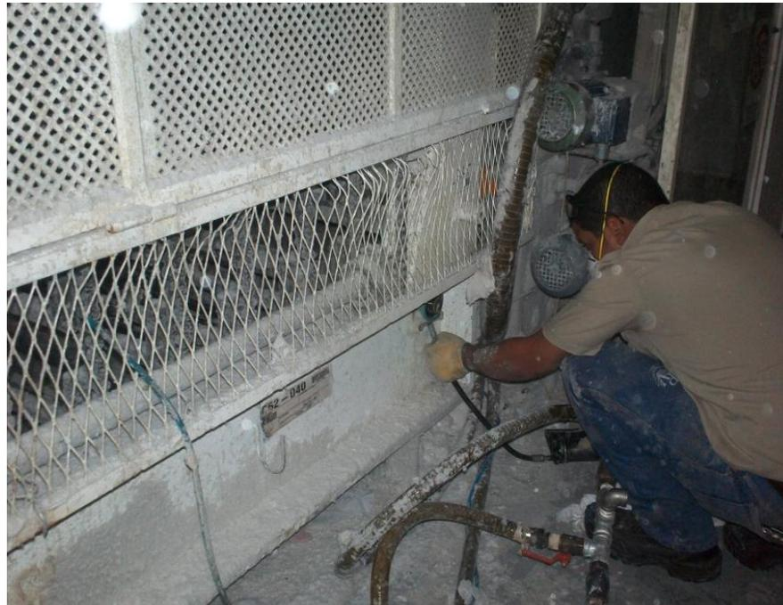
**Figura N° 21: Lubricación de los puntos a una altura menor a 0,5 m.**
