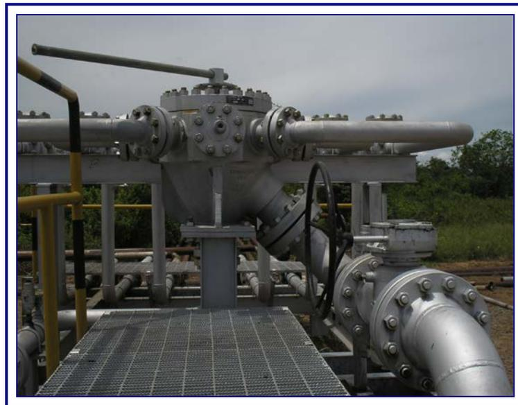
**Figura A.10** Válvula multipuerto manual
