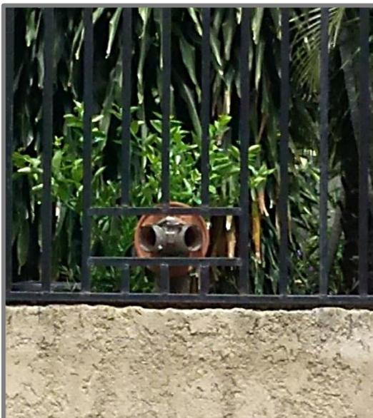
**Figura N° 66.** Hidrante de pared tipo siamesa edificio “Res. Dulce”. Nota: Alfonzo, J. y Ramos, Y. (2016).
