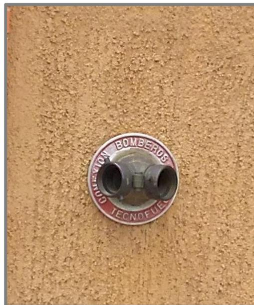
**Figura N° 50.** Hidrante de pared tipo siamesa edificio “Res. Doña Aura”.
