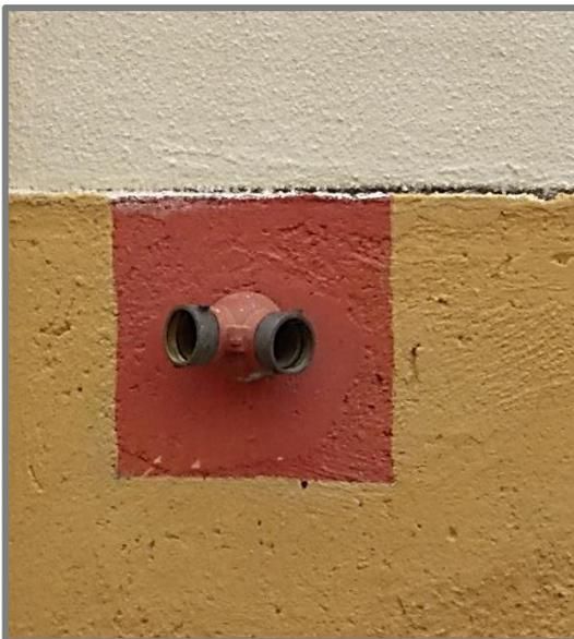
**Figura N° 55.** Hidrante de pared tipo siamesa edificio "Ámbar I". Nota: Alfonzo, J. y Ramos, Y. (2016).
