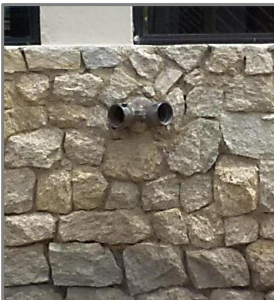
**Figura N° 62.** Hidrante de pared tipo siamesa edificio “Flamboyan”. Nota: Alfonzo, J. y Ramos, Y. (2016).
