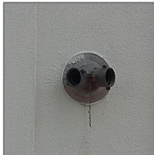
**Figura N° 65.** Hidrante de pared tipo siamesa edificio “Res. Samán”. Nota: Alfonzo, J. y Ramos, Y. (2016).
