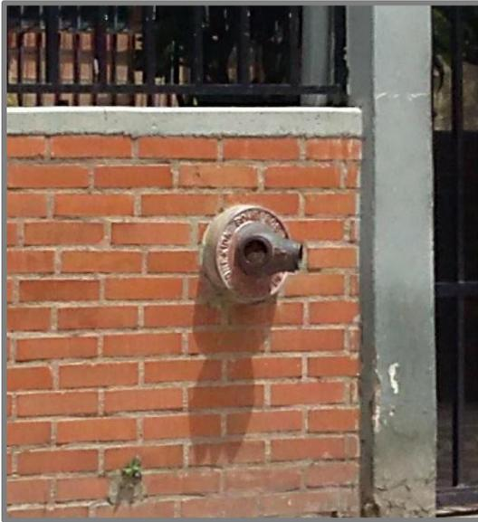
**Figura N° 57.** Hidrante de pared tipo siamesa edificio “Apamate”. Nota: Alfonzo, J. y Ramos, Y. (2016).
