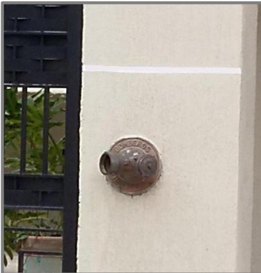
**Figura N° 43.** Hidrante de pared tipo siamesa edificio "Res. Vanessa II".
