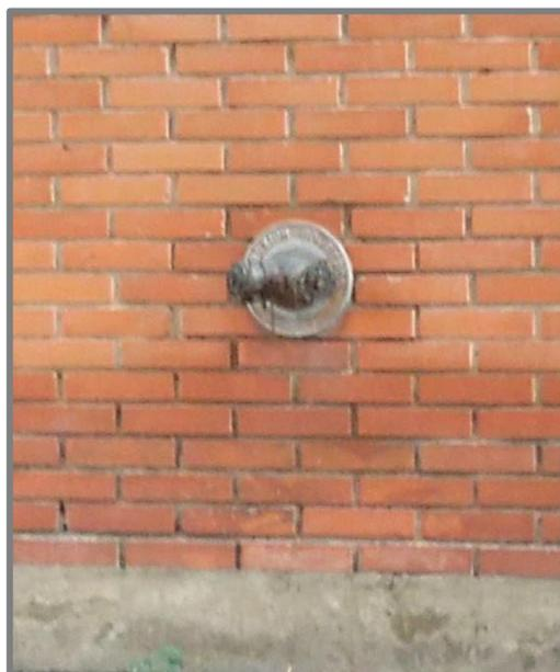
**Figura N° 46.** Hidrante de pared tipo siamesa edificio “Las Aves”. Nota: Alfonzo, J. y Ramos, Y. (2016).
