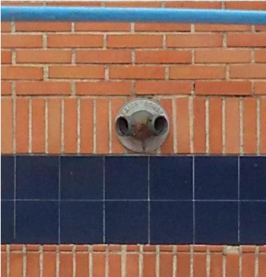
**Figura N° 59.** Hidrante de pared tipo siamesa edificio “Aries”. Nota: Alfonzo, J. y Ramos, Y. (2016).
