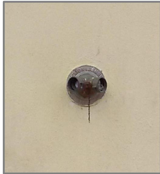
**Figura N° 42.** Hidrante de pared tipo siamesa edificio "Res. Carla". Nota:
