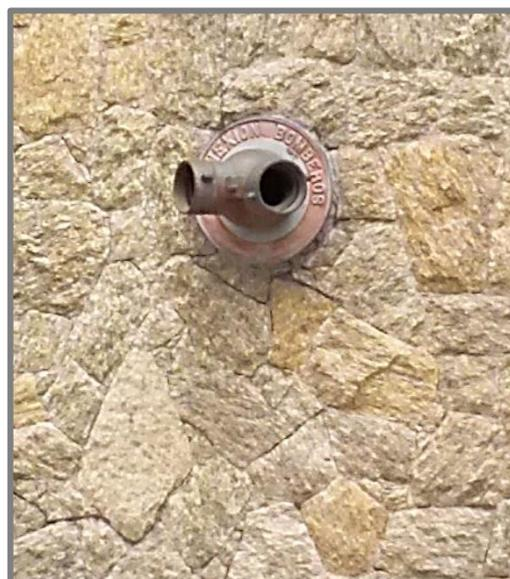
**Figura N° 48.** Hidrante de pared tipo siamesa edificio “Res. Agua Clara”. Nota: Alfonzo, J. y Ramos, Y. (2016).
