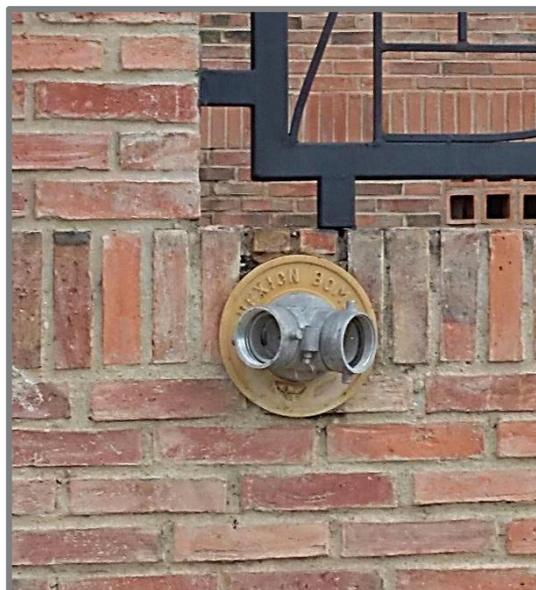
**Figura N° 67.** Hidrante de pared tipo siamesa edificio “Res. Don Jose”. Nota: Alfonzo, J. y Ramos, Y. (2016).
