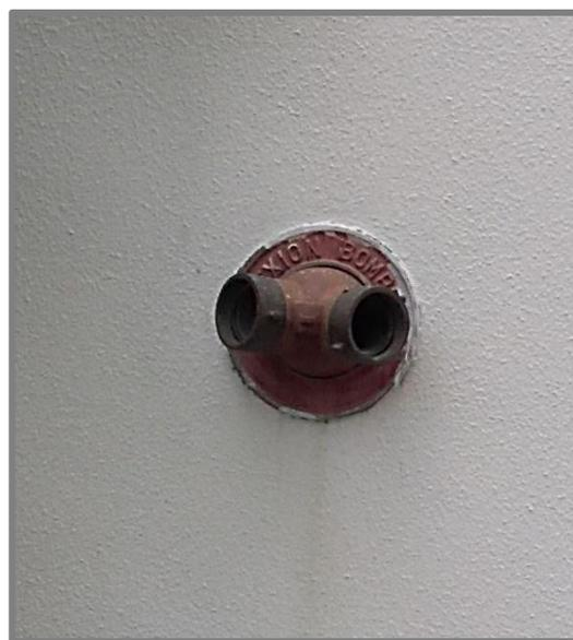
**Figura N° 63.** Hidrante de pared tipo siamesa edificio “Res. AG”. Nota: Alfonzo, J. y Ramos, Y. (2016).
