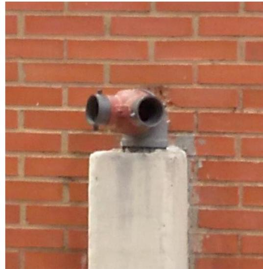
**Figura N° 60.** Hidrante de pared tipo siamesa edificio “La Trinidad”. Nota: Alfonzo, J. y Ramos, Y. (2016).
