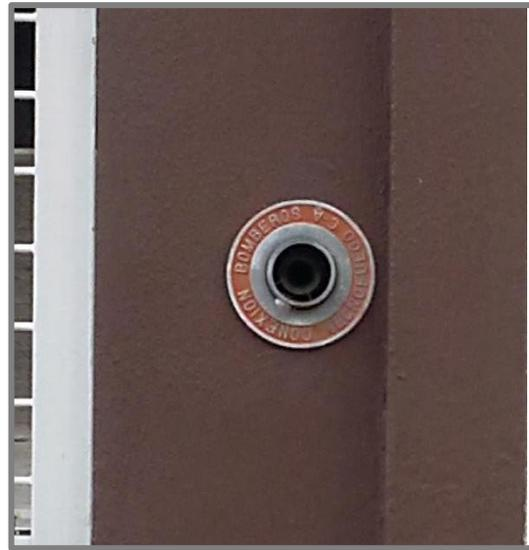
**Figura N° 44.** Hidrante de pared tipo siamesa edificio "Res. Vanessa".
