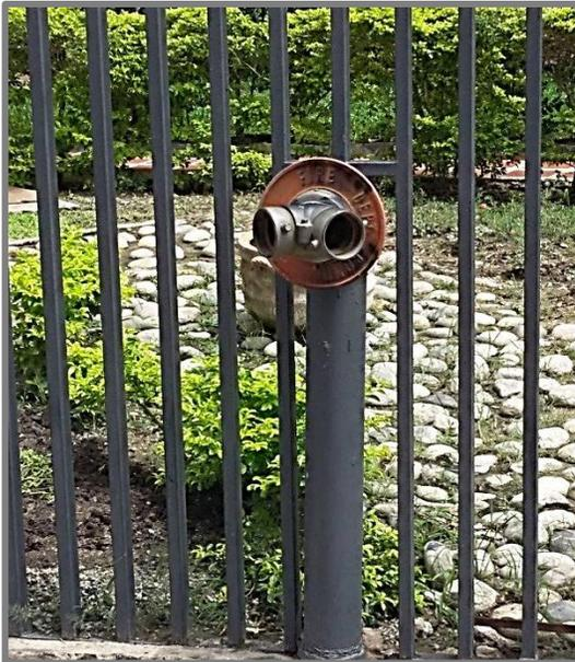
**Figura N° 53.** Hidrante de pared tipo siamesa edificio "Res. Algarroba".
