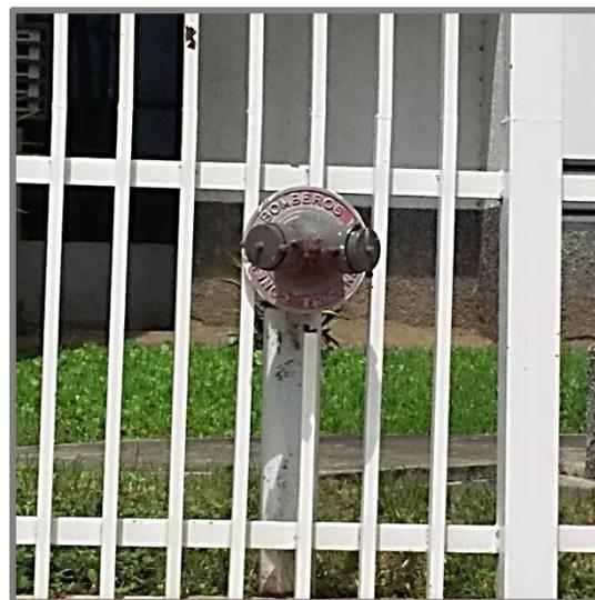
**Figura N° 69.** Hidrante de pared tipo siamesa edificio “Res. Cedro”. Nota: Alfonzo, J. y Ramos, Y. (2016).
