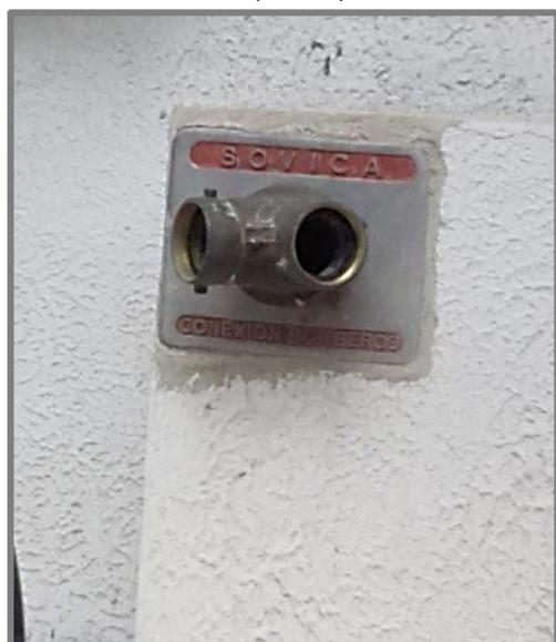
**Figura N° 47.** Hidrante de pared tipo siamesa edificio “Res. Marymar”. Nota: Alfonzo, J. y Ramos, Y. (2016).
