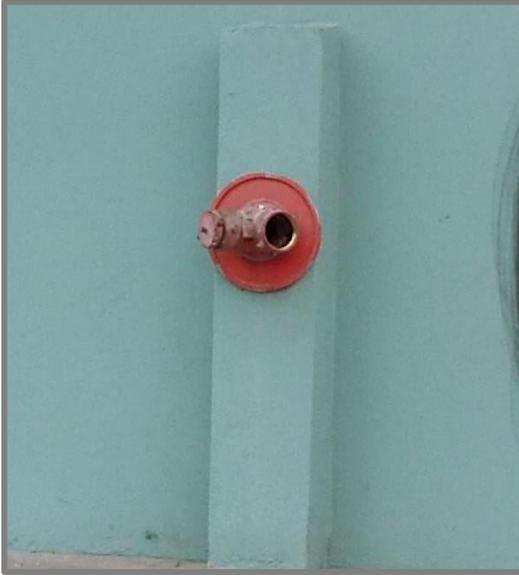
**Figura N° 41.** Hidrante de pared tipo siamesa edificio "Res. Solymas".
