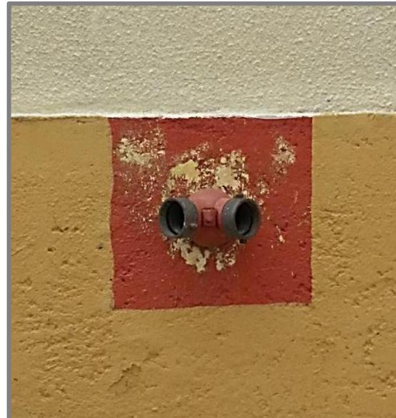
**Figura N° 56.** Hidrante de pared tipo siamesa edificio "Ámbar I". Nota: Alfonzo, J. y Ramos, Y. (2016).
