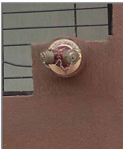
**Figura N° 45.** Hidrante de pared tipo siamesa edificio “Res. Pirámide Palace”. Nota: Alfonzo, J. y Ramos, Y. (2016).
