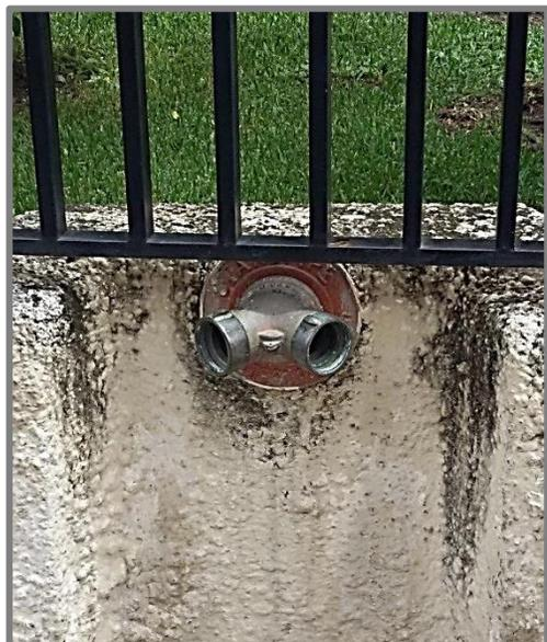
**Figura N° 51.** Hidrante de pared tipo siamesa edificio “Ceiba”.
