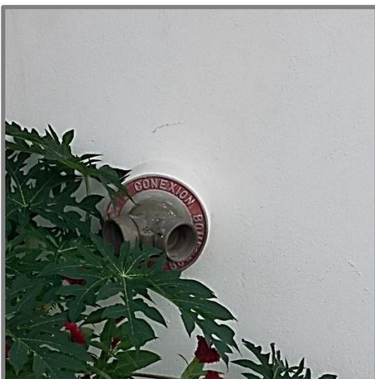
**Figura N° 68.** Hidrante de pared tipo siamesa edificio “Res. Tao”. Nota: Alfonzo, J. y Ramos, Y. (2016).
