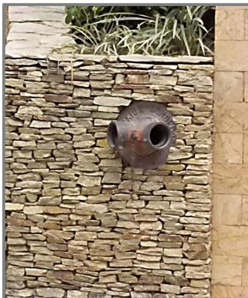
**Figura N° 49.** Hidrante de pared tipo siamesa edificio “Res. Enymar”.
