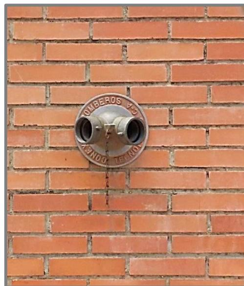
**Figura N° 52.** Hidrante de pared tipo siamesa edificio “La Ciotarrera”.
