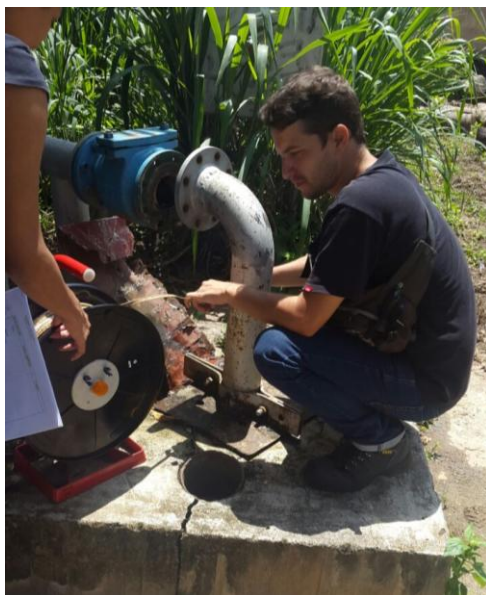
Figura 44. Pozo inactivo. Urbanización Las Aves. Coordenadas 614.023 E; 1.134.115 N. Municipio San Diego, Estado Carabobo. Fecha: 05/09/2016. Fuente: Los Autores.
