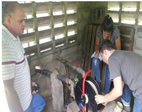
Figura 18. Medición de nivel estático en el Pozo # 1 de A.C conjunto residencial El Tulipán. Coordenadas 613.940,99 E; 1.135.141,28 N, elevación 480 m.s.n.m, Municipio San Diego, Estado Carabobo. Fecha: 24/10/2016. Fuente: Los Autores.
