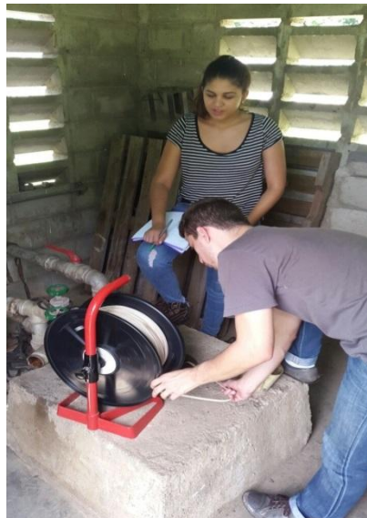
Figura 43. Pozo de observación para la prueba de caudal variable Pozo # 1 de A.C conjunto residencial El Tulipán. Coordenadas 613.940,99 E; 1.135.141,28 N, elevación 480 m.s.n.m Municipio San Diego, Estado Carabobo. Fecha: 24/10/2016. Fuente: Los Autores.
