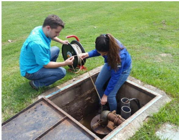
Figura 37. Medición y Lectura de niveles en el Pozo # 3 de Villas de San Diego Country club. Coordenadas 615.974,25 E; 1.137.460,67 N, elevación 495 m.s.n.m Municipio San Diego, Estado Carabobo. Fecha: 12/09/2016. Fuente: Los Autores.
