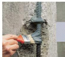
Aplicación de un Inhibidor de Corrosión a la armadura
