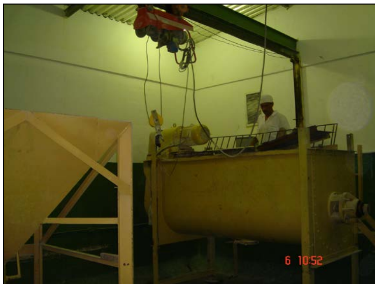
Figura 3.3 Adición de la materia prima en el área de Premezcla
