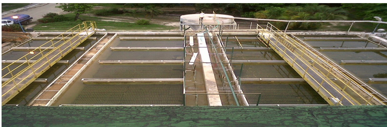
Figura 4.11 Vista aérea de los sedimentadores
