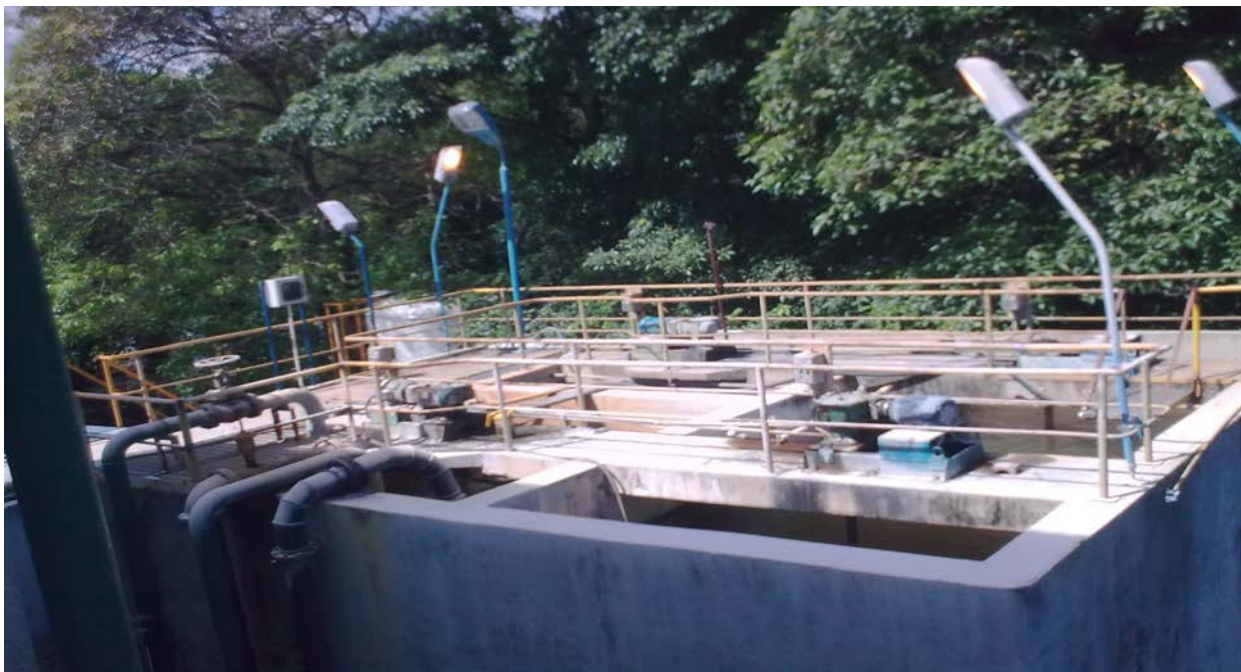
Figura 4.10 Mezcladores rápidos M-1, M-2, M-3 y M-4
