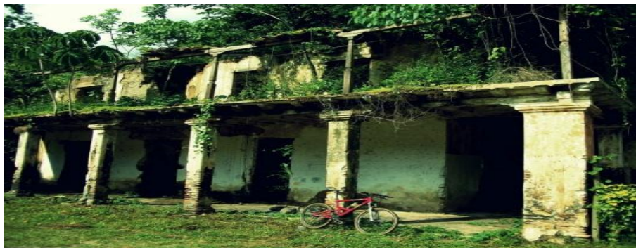
Ruinas de antiguas oficinas administrativas en "la Unión"
