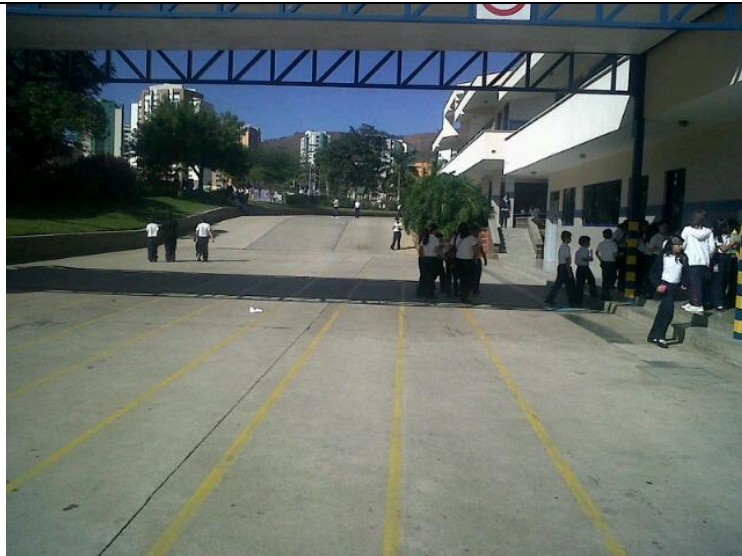
Entrada principal a las instalaciones: oficinas, salón de usos múltiples y otras áreas.
