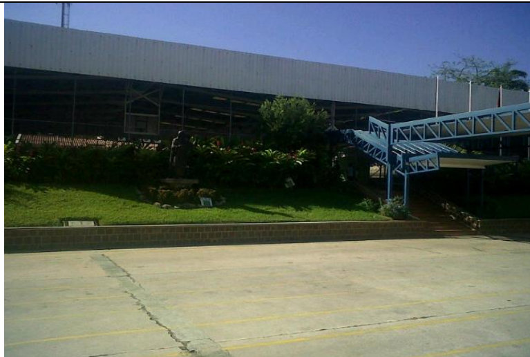
Una de las canchas deportivas cubiertas.
