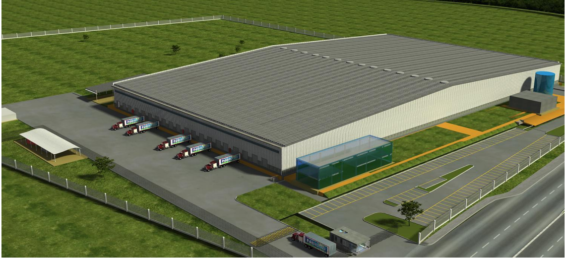
Figura N°37. Centro de Distribución Nestlé en Morón.
