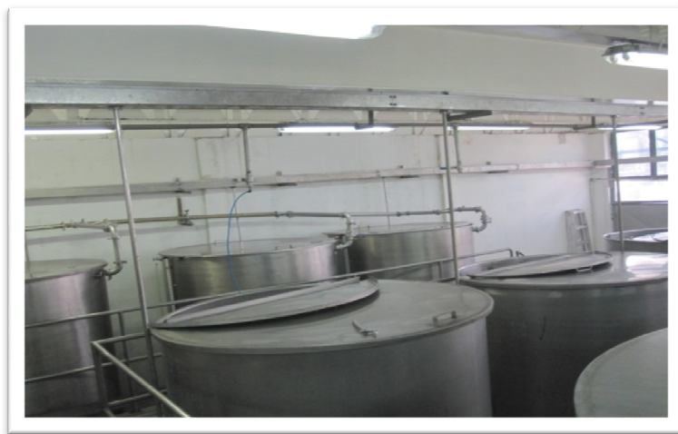
Figura 15. Sala de preparación
