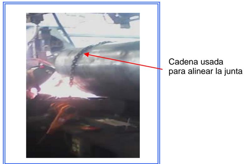
**Figura 3.20:** Soldadura interna manual.
