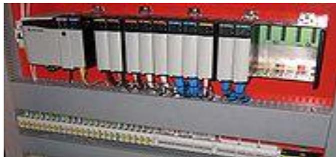
**Figura 2.1. PLC moderno instalado (2008) dentro del tablero eléctrico**
