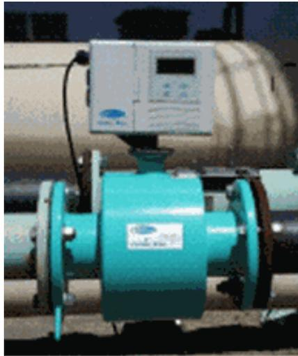
**Figura 2.15:** Medidor-Transmisor de Flujo Magnético
