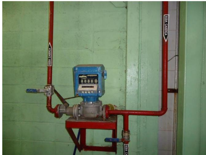
**Figura 4.8:** Contador o medidor de flujo schlumberger/actaris modelo neptune.
