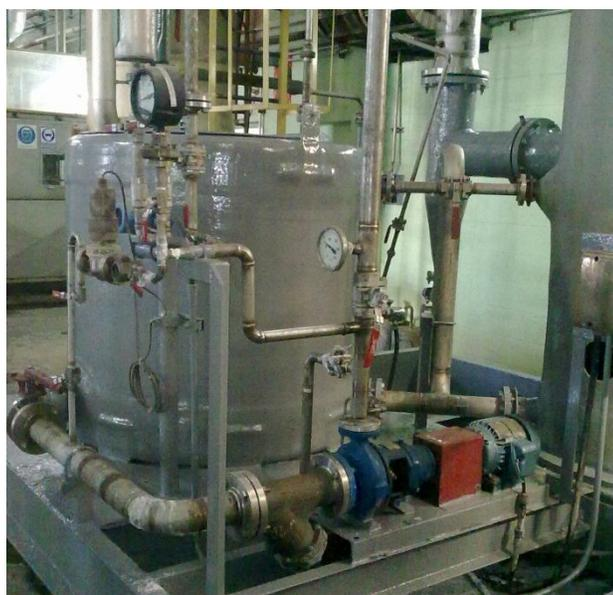
**Figura 1.1:** Tanque de recirculación, Etapa de lavado de gases
