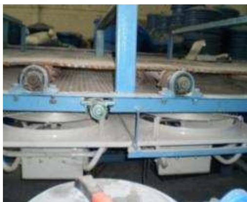
Figura 4.20. Ventiladores de Enfriado
