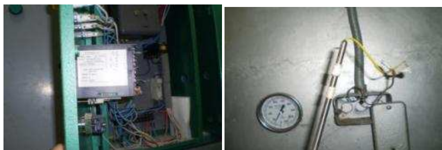
Figura 4.3. Lógica cableada y Control analógico
