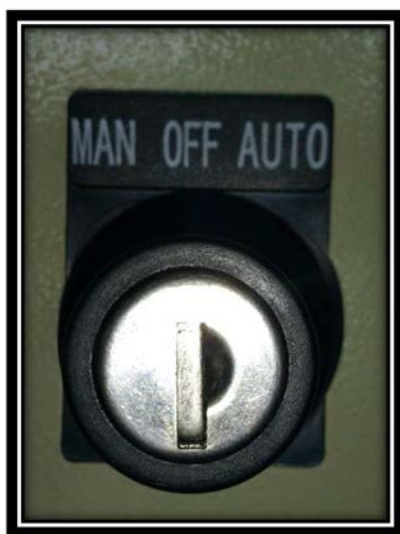
Figura 4.18 Llave de selección (Derecha: modo automático, Izquierda: modo manual)
