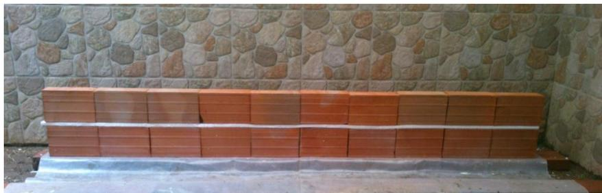
**Figura 11.** *Distribución de bloques que conforman el muro.*
