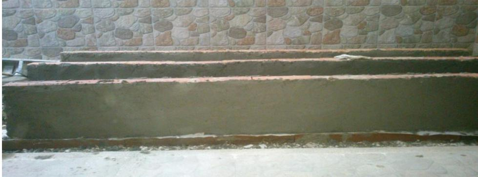
**Figura 15.** Finalización del revestido de muros.
