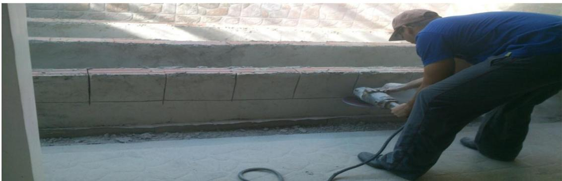
**Figura 16.** Separación de bloques.
