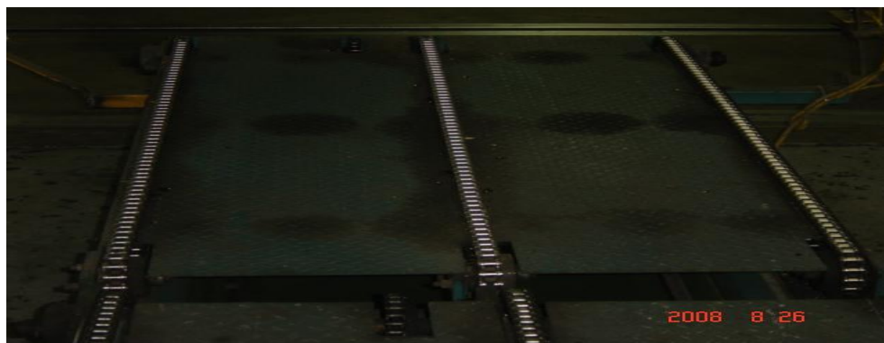
Fig. 4.14. Transportador salida del ascensor.
