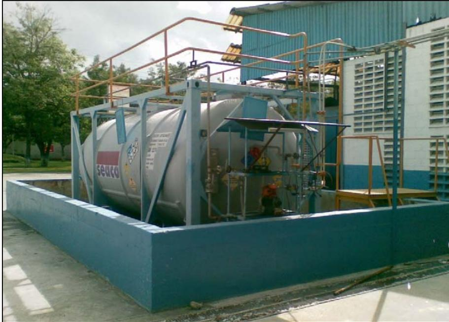
Figura 3.17 Tanque de almacenamiento de peróxido de hidrógeno ubicado a las afueras de la planta de destintado.
