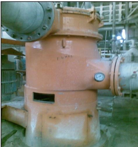
Figura 3.11 Depurador vertical secundario (Fine screen N° 2).
