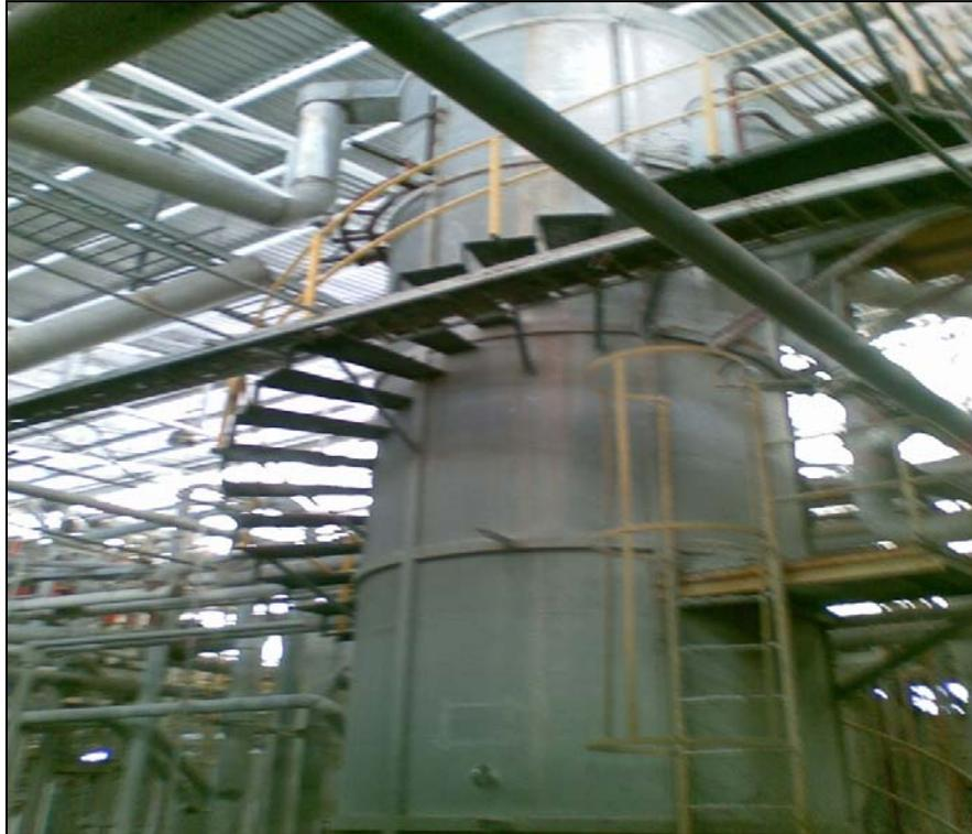
**Figura 3.19 Torre de blanqueo con hidrosulfito en la planta de destintado**
