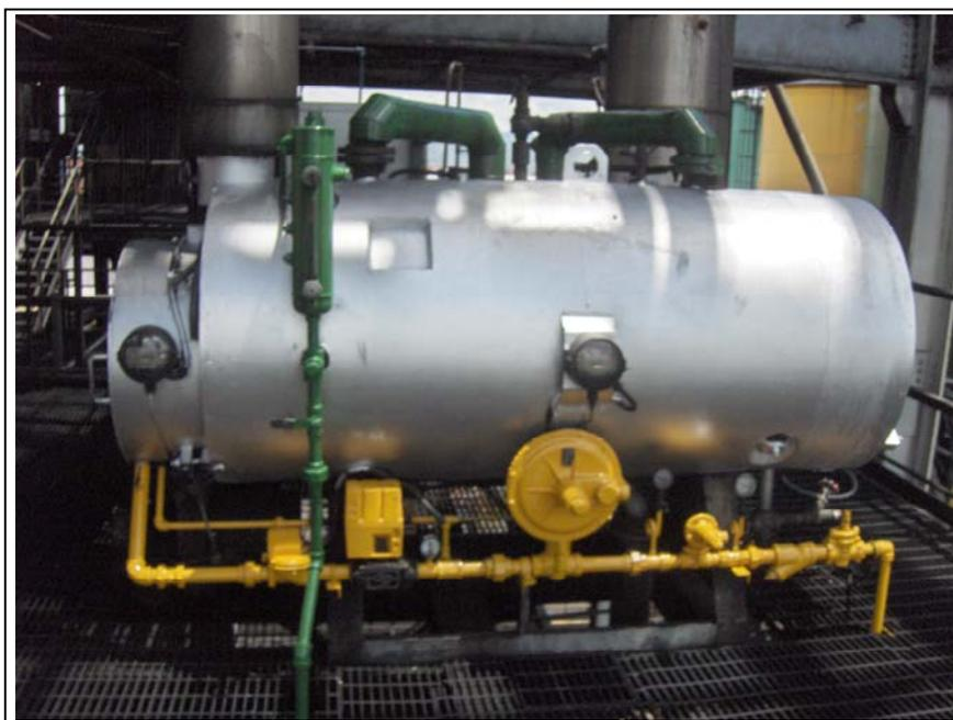
**Figura 4.3 Calentador de agua del sistema de calentamiento del área de peletización**
