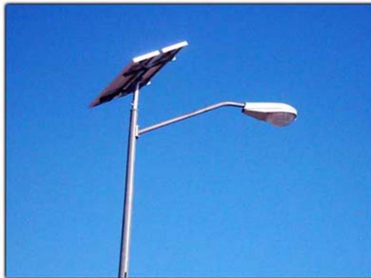
Figura 4.7 Imagen de una luminaria para exteriores, alimentada por un panel solar
