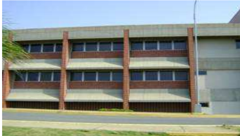
Figura 8. Vista del ala noreste, lado exterior, fachada.
