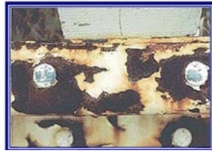
Figura 3: muestra de corrosión general o uniforme (UNLP 2007)
