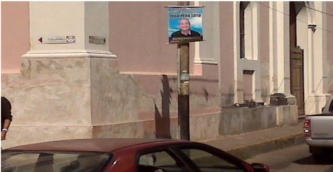
Restauración inadecuada de la iglesia San Francisco
