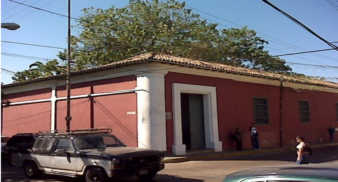
Casa de la estrella (Vista diagonal)
