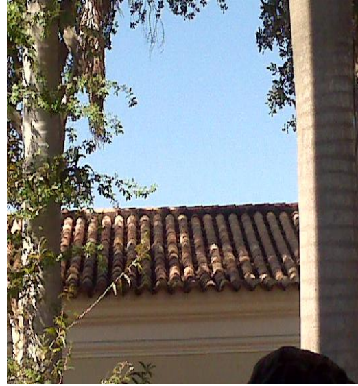
Techo de teja
