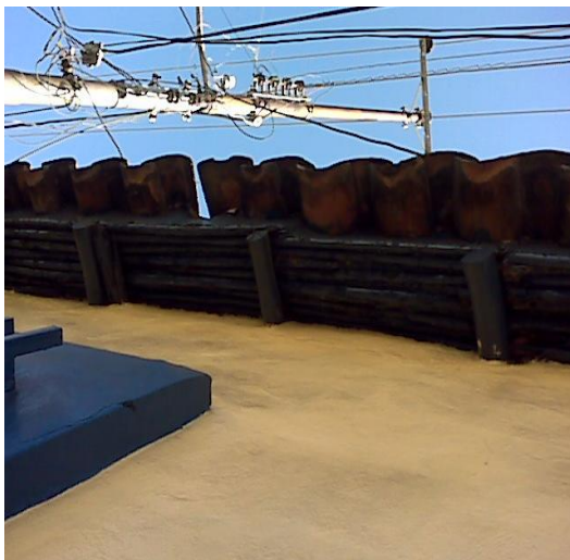
Cornisa de caña de casa colonial
