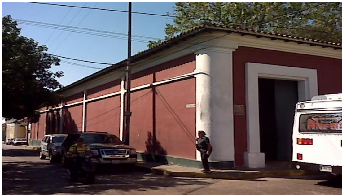
Casa de la Estrella (vista lateral)
