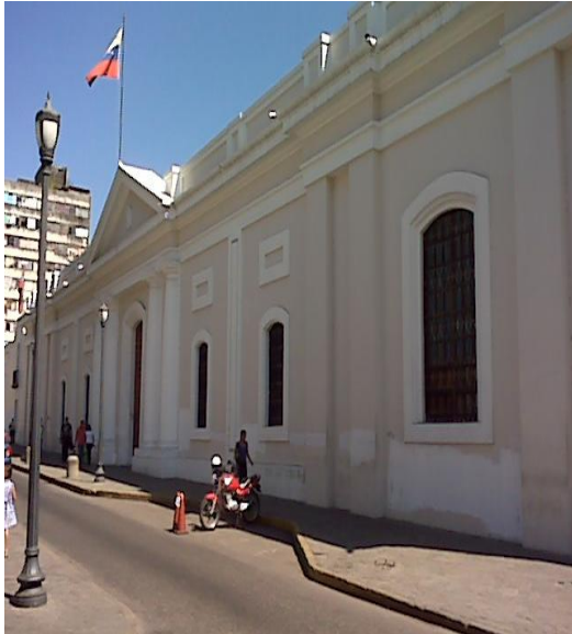
Capitolio (calle Montes de Oca)
