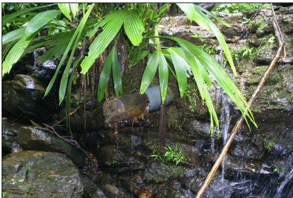
Figura 20. Figura 5. Tuberías de Purga del Dique la Fabianera.
