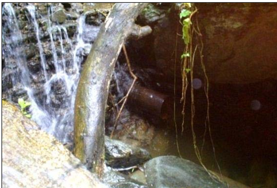
Figura 21. Tuberías de Purga del Dique la Fabianera.
