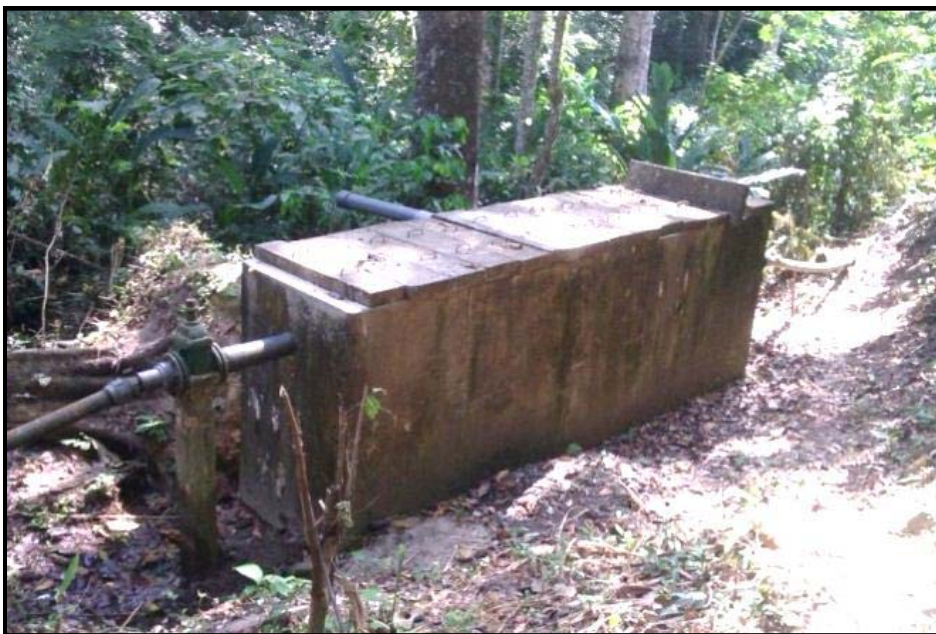
Figura 27. Desarenador Dique la Fabianera.
