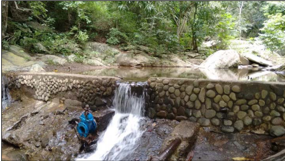
Figura 6. Vista del dique toma sector La Manga
