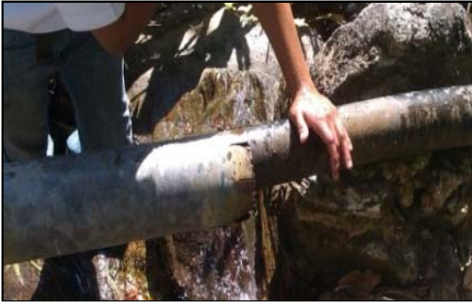
Figura 24. Cambio de diámetro y material en tubería de aducción Dique la Fabianera.
