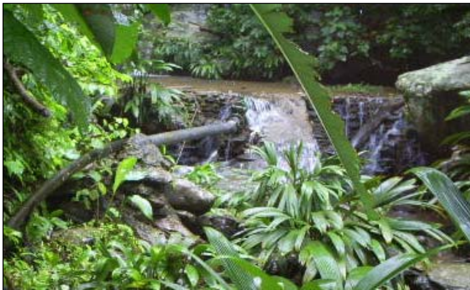
Figura 18. Vista de Frente del Dique la Fabianera Vigirima Municipio Guacara Edo. Carabobo.
