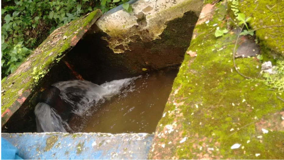
Figura 8. Vista tanquilla – desareneador del dique toma sector La Manga.
