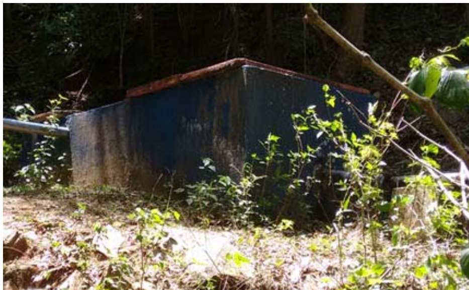
Figura 7. Vista tanquilla – desareneador del dique toma sector La Manga.
