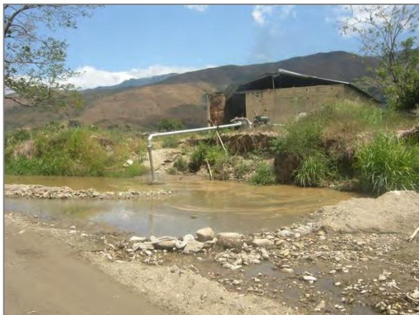
**Figura 32.**Extracción del agua mediante captación directa desde el río Chirgua
