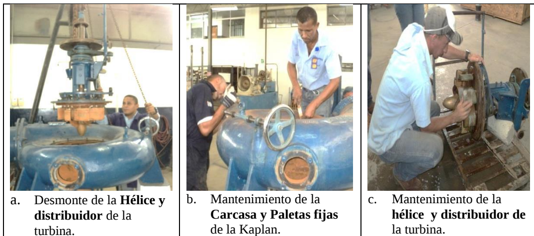
Figura 4.49. Mantenimiento mecánico de la turbina Kaplan.
