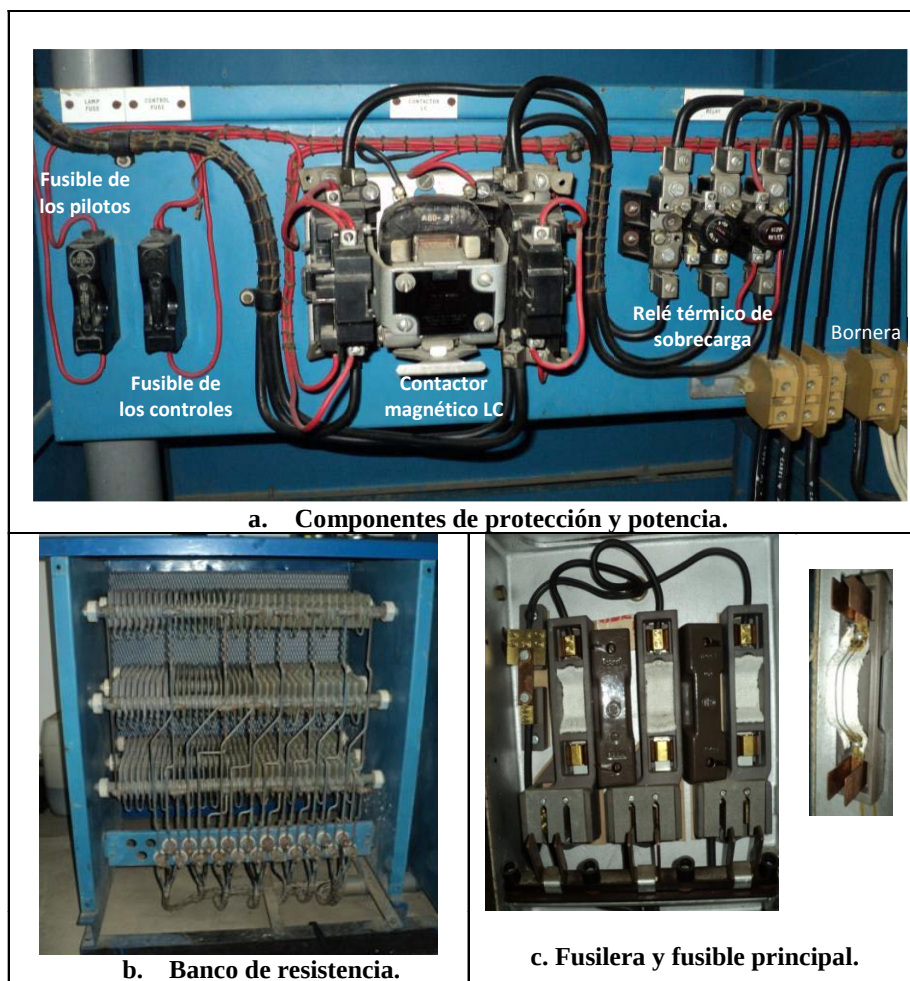
Figura 4.13. Componentes de protección y potencia del panel de control del banco de turbina Kaplan
