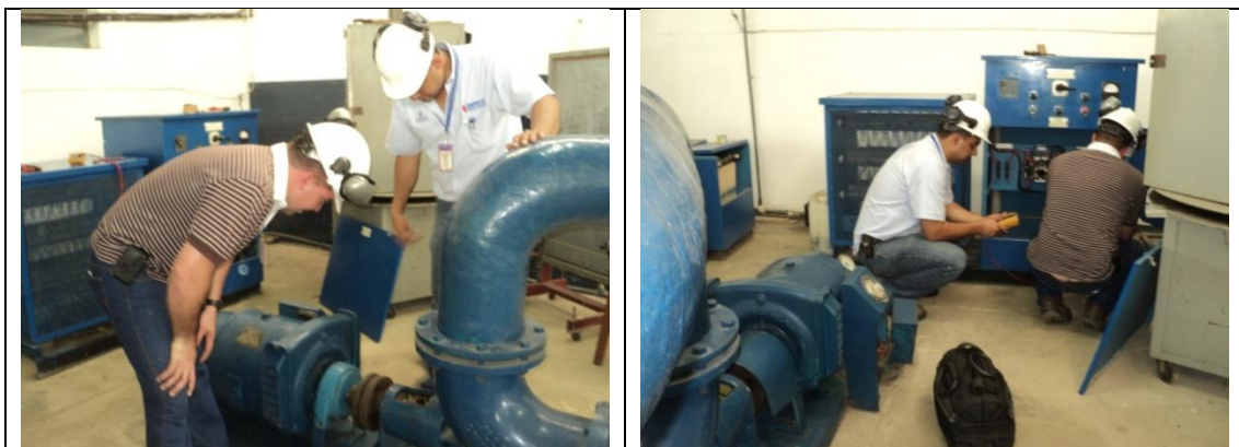
Figura 4.48. Arranque al vacío de la Unidad motora del banco de Turbina Kaplan.
