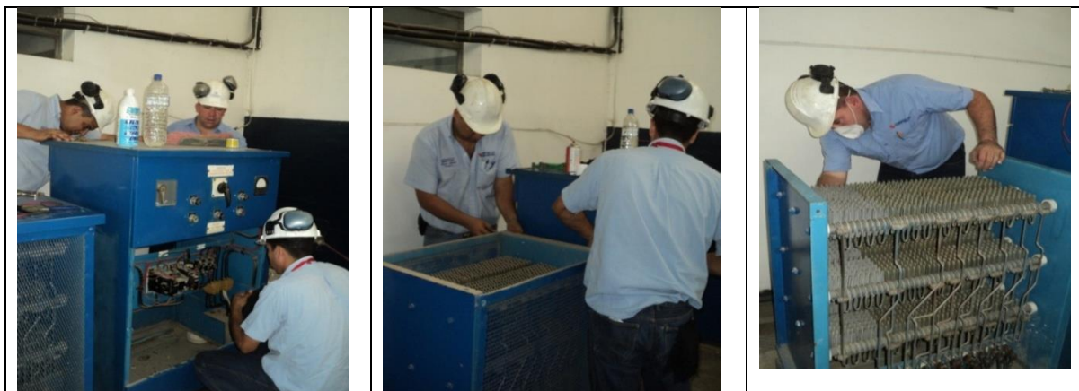
Figura 4.46. Mantenimiento del Panel de control del Banco de Turbina kaplan.
