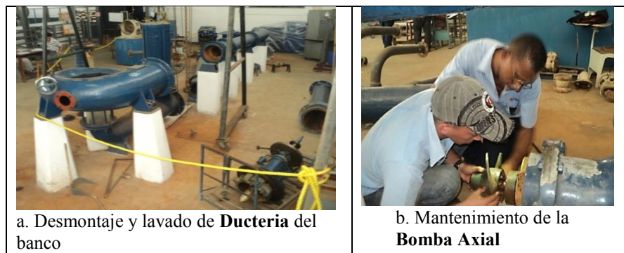
Figura 4.50. Mantenimiento de la ducteria y bomba axial.
