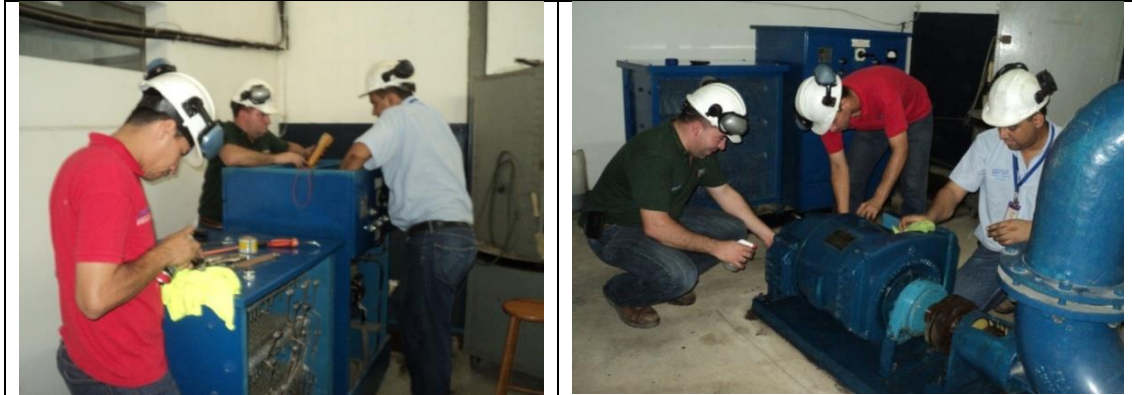
Figura 4.47. Evaluacion del estado de la Unidad motora del banco de Turbina Kaplan.
