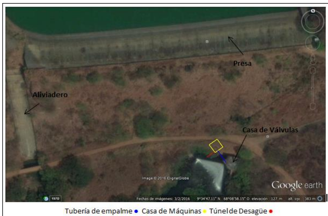
Figura 4.33. Ubicación de las obras civiles en el Embalse El Pueblito. Alternativa II
