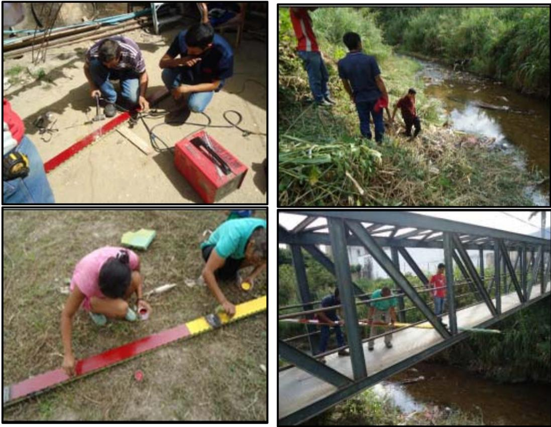
**Figura 39.-** Instalación de la escala linnimetrica en la CPLA-MN
