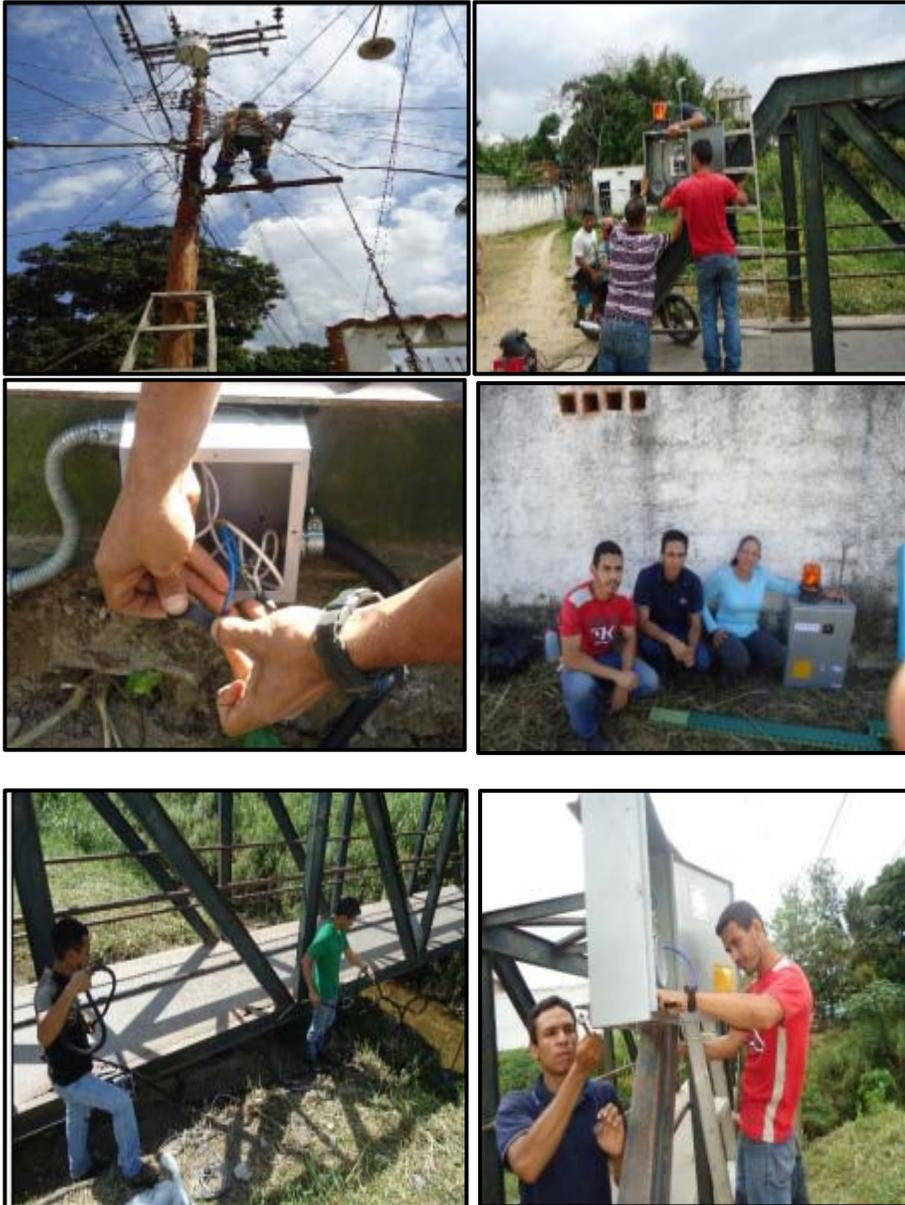
**Figura 41.-** Instalación del dispositivo de control de nivel en la CPLA-MN
