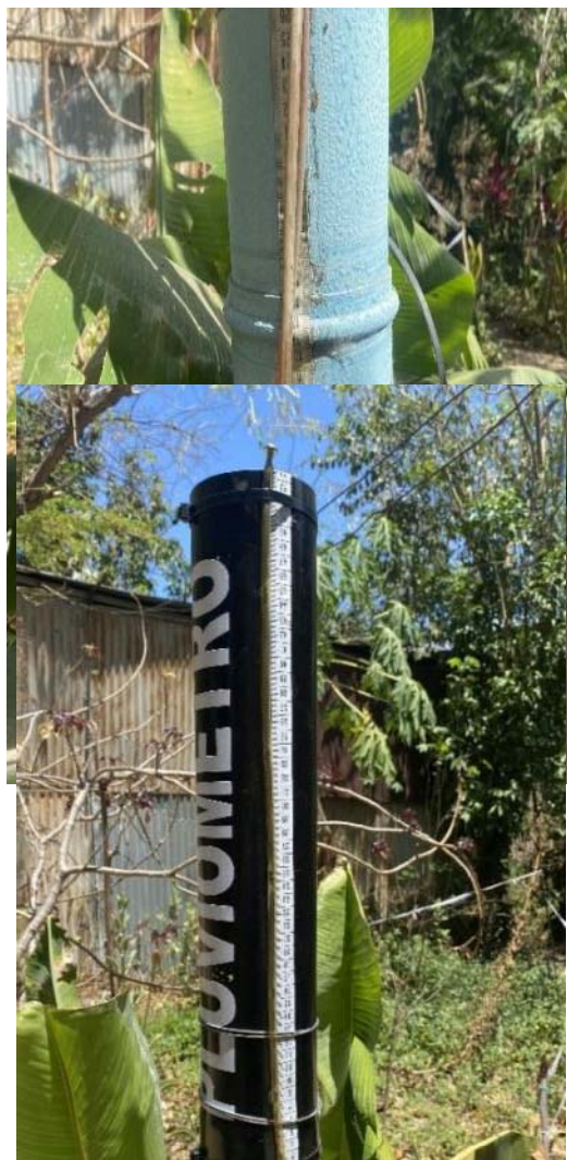
Figura 36. Sustitución del pluviómetro comunitario. Fuente: Colmenares I. (2023)
