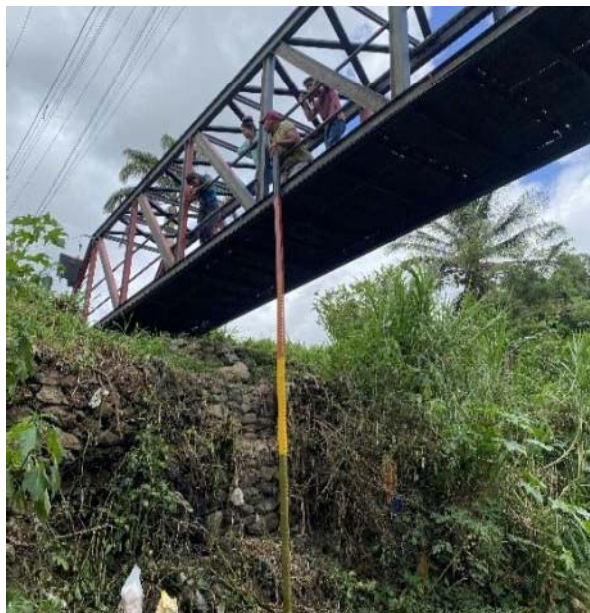
Figura 31. Restauración y actualización del limnómetro. Fuente: Colmenares I. (2023)
