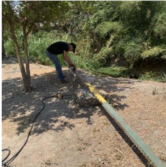
Figura 7. Restauración del limnómetro.
