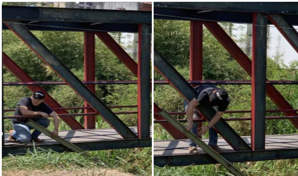
Figura 6. Desmontaje del limnómetro.
