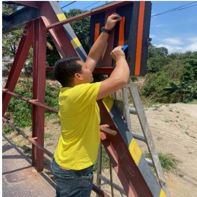
Figura 14. Instalación del D.A.I.L.A. en el sitio definitivo.
