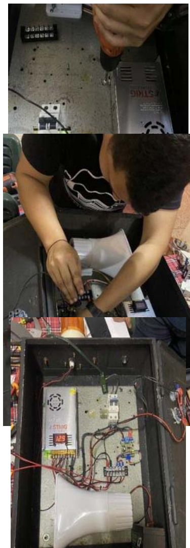
Figura 13. Instalación de nuevos componentes del D.A.I.L.A.
